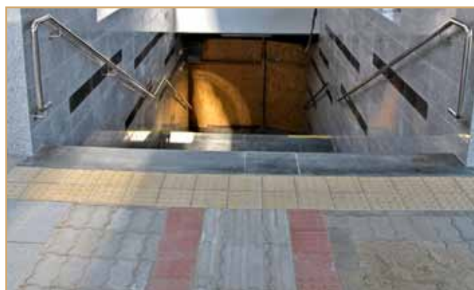
Potešujúcou správou je aj fakt, že pri nutnej oprave nástupištia sa popri položení pôvodnej, nie tak starej zámkovej dlažby, myslelo aj na hendikepovaných ľudí. A tak je dlažba doplnená aj plastickými pásmi pre orientáciu slabozrakých a nevidiacich.
