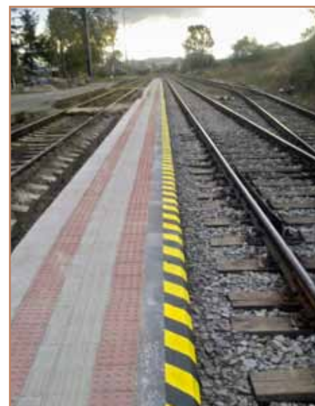
Nástupište č. 2 (medzi prvou a druhou koľajou) je už upravené, chýba ešte bezpečnostný náter na druhej strane. Foto: KDS
