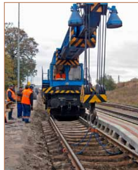
Smerové a výškové úpravy prvej a druhej koľaje sú už zrealizované.
