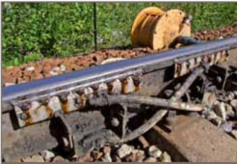
Dvojica mazacích líšt zabezpečuje prechod mazacieho tuku na vnútornú hranu hlavy koľajnice.
