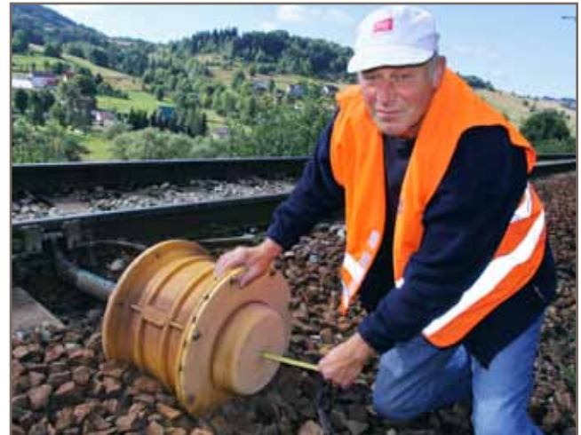
Pavol Ďurana, správca ŽI z Čadce, metrom kontroluje množstvo mazacieho tuku v zásobníku. Meria polohu membrány pod žltým krytom, na ktorú pôsobí pružina a ktorá tlačí mazivo do mechanickej pumpy. Ak je membrána príliš hlboko, zásobník je prázdny.
