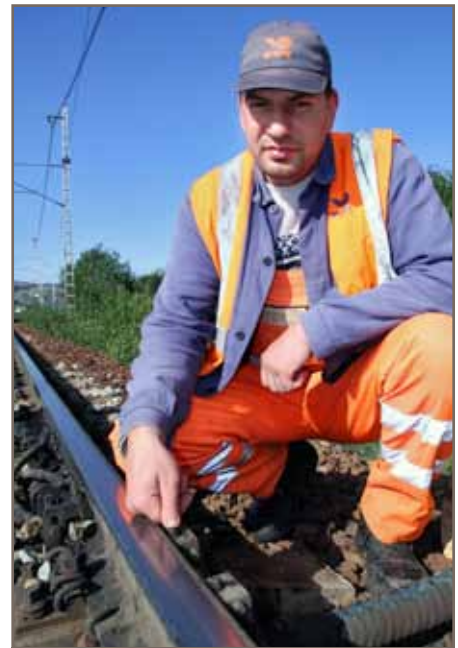
Kontrolór trate SMSÚ ŽTS TO Žilina Pavol Chrobák stláča palcom piest, umiestnený na vonkajšej strane koľajnice. Ak na tento bod pôsobí okolesník železničného vozidla, aktivuje mazník a vytlačí tuk z mazacích líšt.
