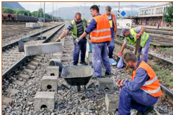
Nástupištné hrany z betónových dielov Tischer, ako aj zámkovú dlažbu ukladali v Rožňave zamestnanci KDS Košice s. r. o.
