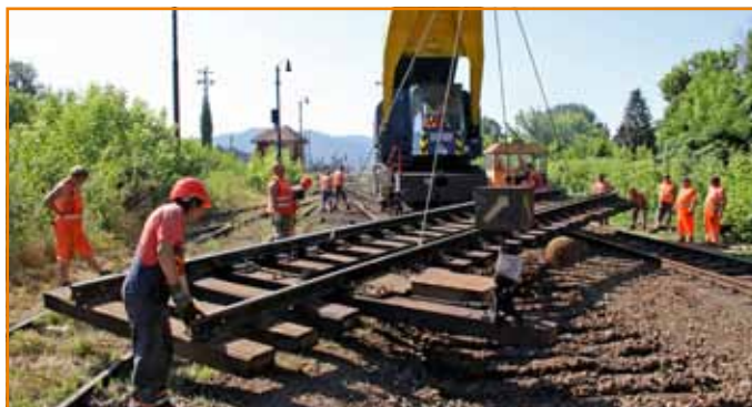
Každú zo šiestich obnovovaných výhybiek vo Filákovke najskôr vytrhol koľajový žerjav, až tak mohli traťoví robotníci pod nimi obnoviť koľajové lôžko.
