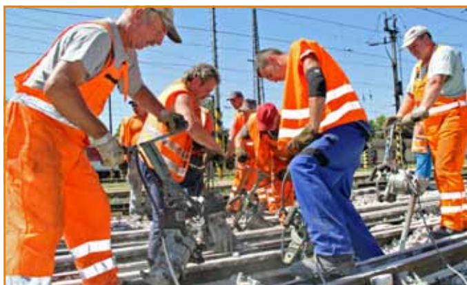
Osem chlapov manuálne podbijať križovatkovú výhybku. Škoda len, že takto museli míňať svoju energiu v súčasnej pretechnizovanej dobe.
