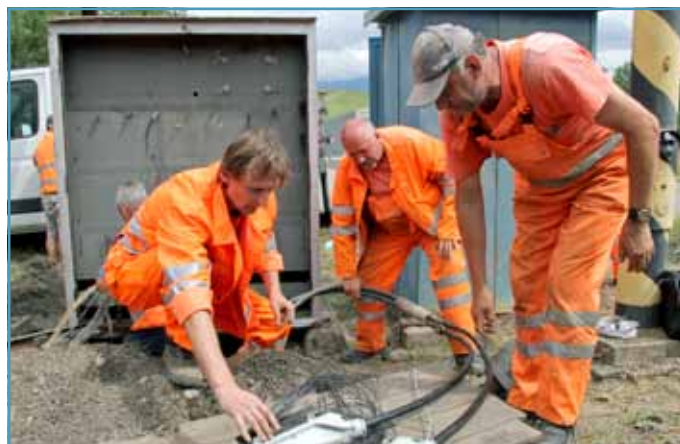
Provizórne prepojené káble sa museli opatrne položiť, pretože pri rozpojení čo i len jedného vodiča by nastala porucha autobloku.
