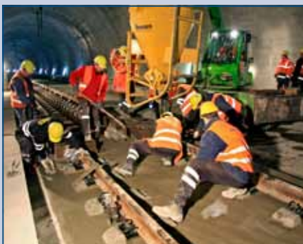
Január 2012 – montáž pevnej jazdnej dráhy
