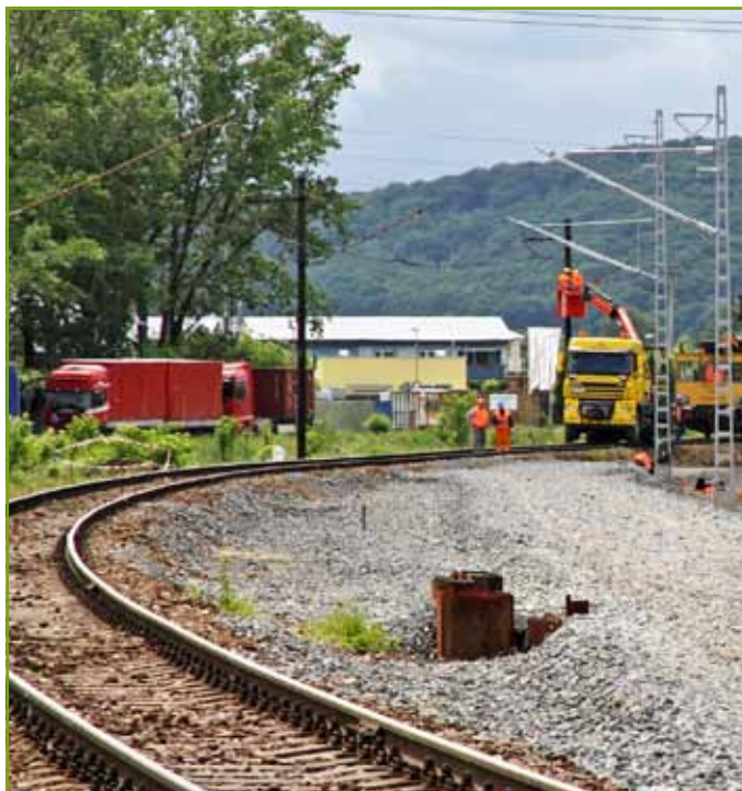
Preloženie trate si vyžiadalo veľké množstvo prípravných prác, jednu z nich bolo aj nové trolejové vedenie.
