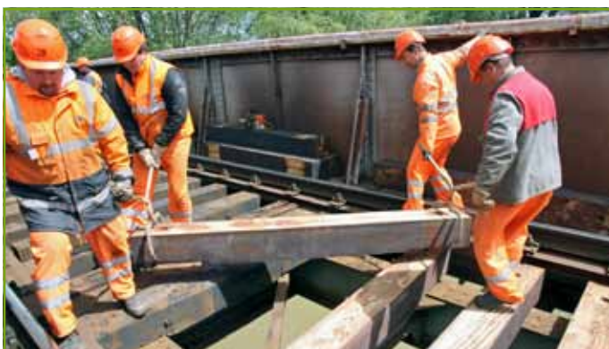
Stopercentné zosúladenie a absolútna disciplína je potrebná aj pri presune a osadení novej mostnice. Svoje o tom vedia aj naši kolegovia z SMÚ M0 Prešov.
