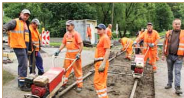
Zamestnanci SMSÚ ŽTS TO Žilina opravovali priecestia počas denných výluk, cestná doprava bola presmerovaná cez dočasne vybudované priecestia.
