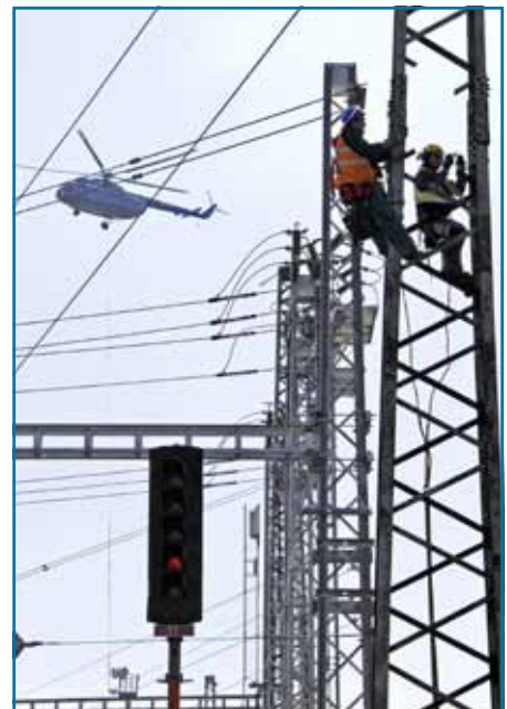
Vysoké stožiare sa museli najprv rozdeliť na dve časti a postupne ich vrtuľník na lane prenášal a ukladal na zberné miesto. Náročná práca bola výborne skoordínovaná a tak sa všetko podarilo na jednotku. Aj záber na obálke je zo soboty 4. mája 2013.
