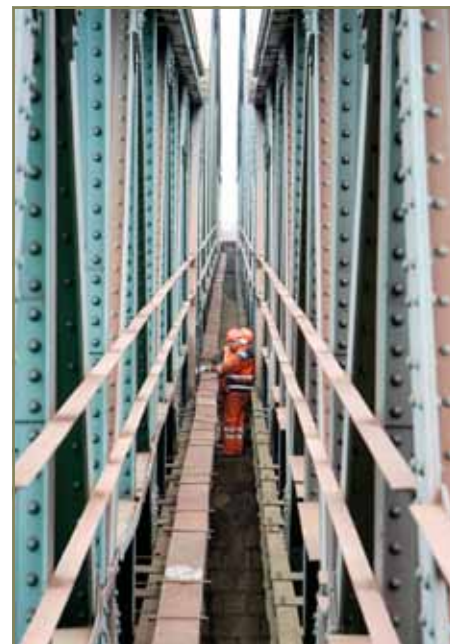
Práca zamestnancov mostných obvodov je náročná a nebezpečná. Pohľad na mostárov stojacich na pilieri v stiesnenom priestore medzi dvoma mostami hovorí za všetko.
