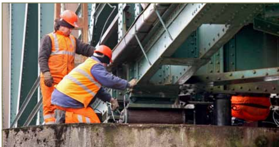
Až po nadvihnutí mostov sa mohli valce ložísk nastaviť do správnej polohy.
