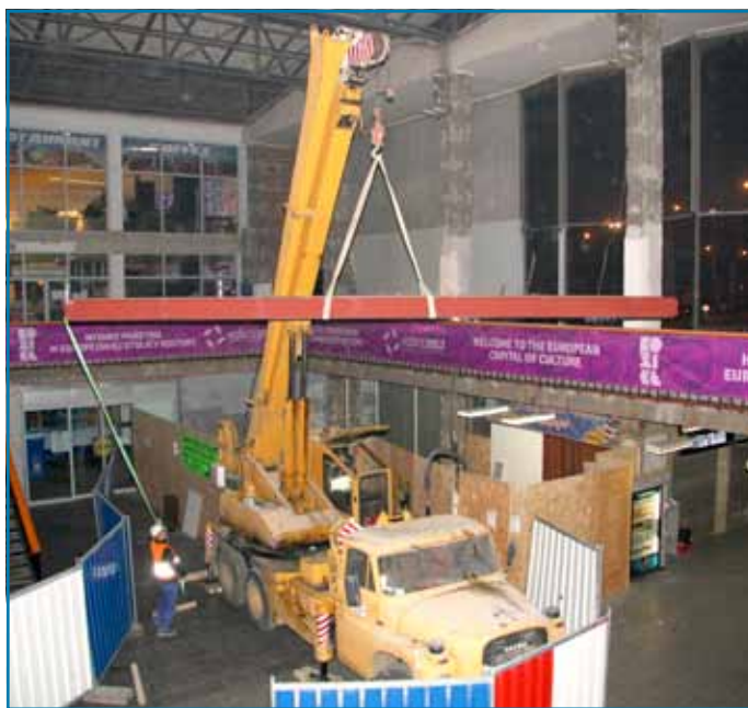
Mnohých cestujúcich prekvapil vo vestibule autožeriav, nevyhnutný pri prenášaní oceľových nosníkov.
