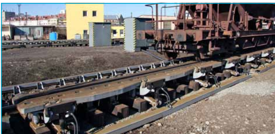
Pôvodné dvojkolajnicové brzdy na stlačený vzduch nahradili jednokolajnicové brzdy s hydraulickým ovládaním umiestneným priamo v koľajisku. Prídržnica prímontovaná na protiahej koľajnici zabraňuje vykoľajeniu voza pri brzdení.
