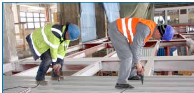
Montované trapezové plechy sú základom podlahy budovaného podlažia.
