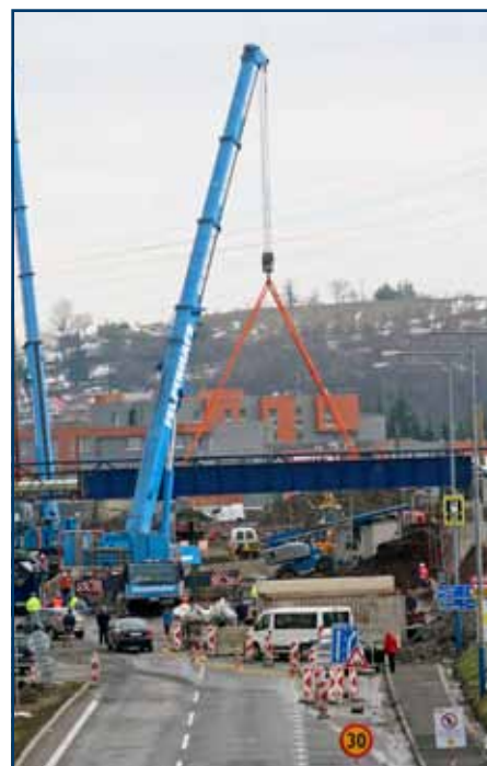
...časť nového mosta. Pomocou žeriavu na opory a piliere osadili dva diely ocelevej konštrukcie mosta a následne ich zvarili.
