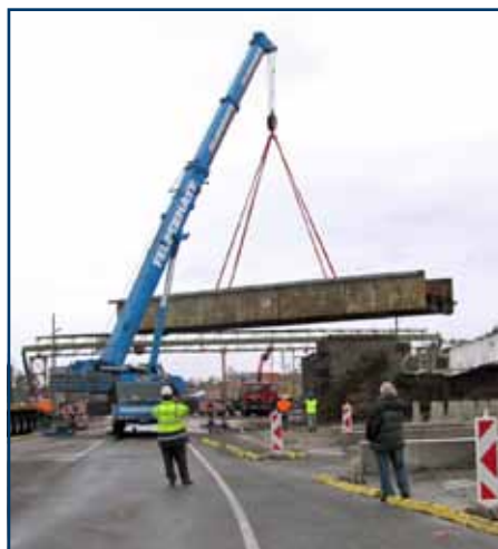
Starý železničný most skončil na šrotovisku. Predtým bol rozpálený na menšie kusy.
