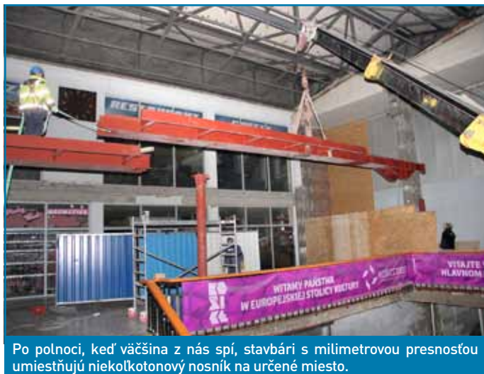
Mnohých cestujúcich prekvapil vo vestibule autožeriav, nevyhnutný pri prenášaní oceľových nosníkov.
