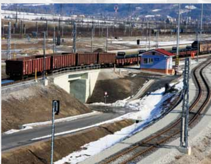
Spádovisko Váh so zväzným pahorkom a 18 smerovými koľajami je riadené elektronickým spádoviskovým zariadením, ktoré ovláda výhybky a 126 koľajových bŕzd. Triedenie súprav nákladných vlakov je plne automatické. Podľa plánov mala Žilina – Teplička denne spracovať 1200 vozňov, reálne je ich takmer 650 vozňov. Stanica dokáže vybaviť 21 končiacich a 21 východiskových vlakov.
