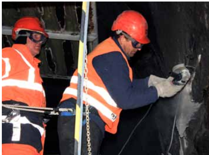
Tunelári Pavol Pavlov a Peter Halaj pri rezaní tvrdého betónu otupili niekoľko rezných kotúčov.
