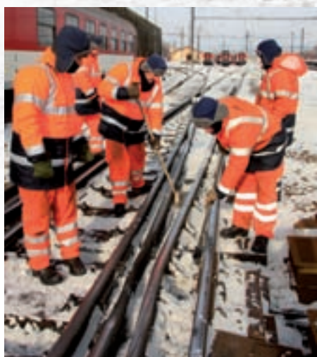
V Košiciach najväčšie problémy spôsobuje zafúkavanie výhybiek snehom. Silný mráz, vietor a sneženie spôsobovali ich odstavenie, čomu sa v zimnom počasí nedá predísť. Iba neustála prítomnosť a fyzická práca železničiarov v koľajisku ich udržiavala prevádzkyschopné.
