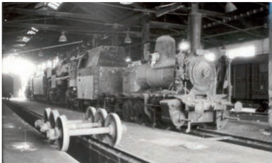
Rušeň 422.0108 bol takto zachytený počas opravy v rušňovom depe Bratislava východ vo februári 1987. V pozadí staja ďalšie zachránené parné rušne.
