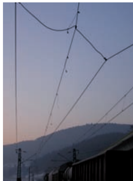
Strhnutých bolo 93 trolejových vešiakov, tzv. lanička. Tie sú fixované na nosnom lane a držia trolejový drôt v požadovanej horizontálnej výške 5,5 m.
