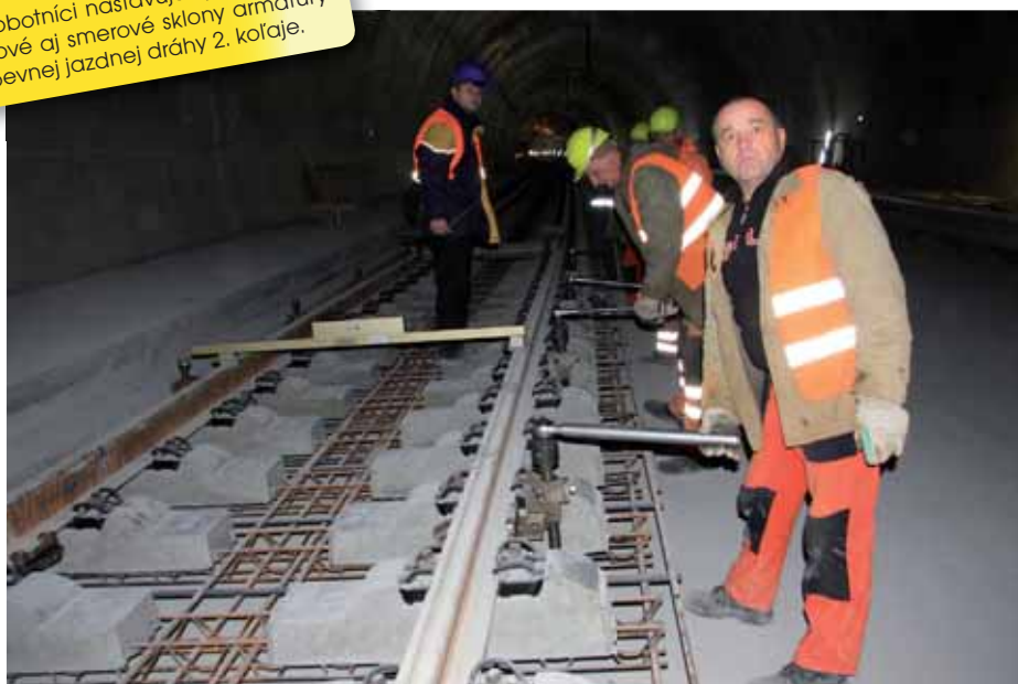
Práce na sekundárnom ostení aj klenbe tunela sú ukončené, v tuneli je realizovaná betonáž monolitickéj nosnej železobetónovej dosky.
