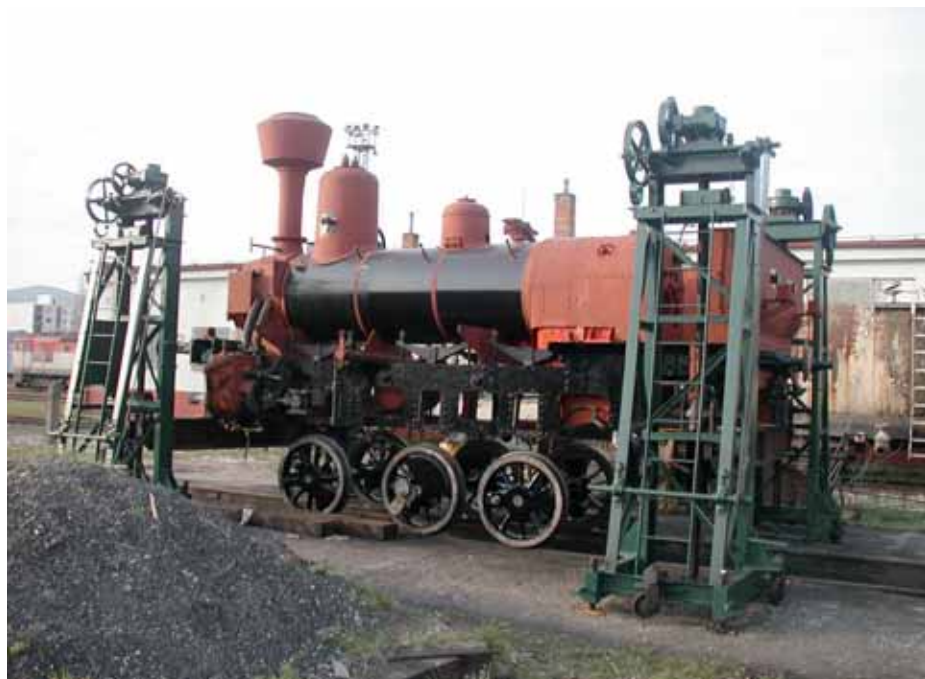
Z rušňa 310.097 bolo počas opravy potrebné vyviazať aj dvojkoľesia. Stalo sa tak pomocou múzejných ručných travozových zdvihákov z 30. rokov 20. storočia.
