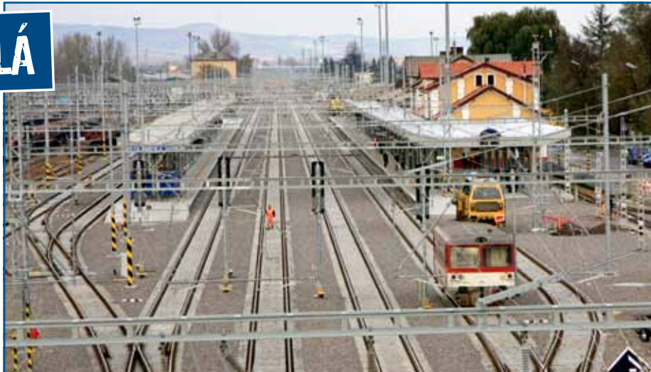
Rýchlosť výstavby svedčí o tom, že všetko správne klapalo. V stanici bolo položených 5600 metrov kolajového zvršku typu UIC a 32 výhybiek, 31-tisíc kubíkov štrku navážalo 65 vlakov.
