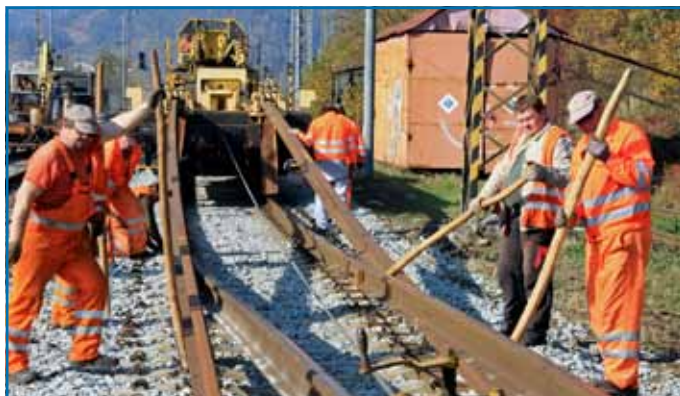
Zamestnanci SMSÚ ŽTS ZRS Vrútky vymieňali koľajnicové pásy pomocou súpravy SDK II. Na oprave 711-metrovej koľaje sa významným podielom pričínili aj chlapi z SMSÚ ŽTS TO Trenčín.
