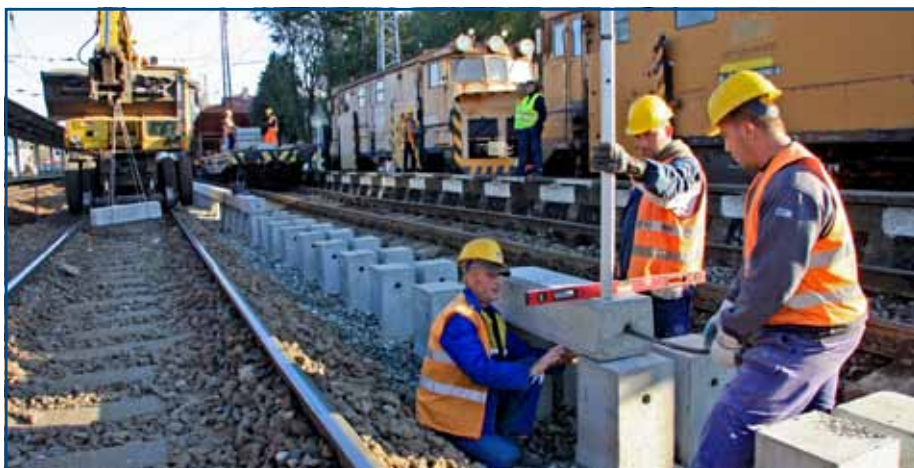
Perón budovali Železničné stavby a. s., Košice.
