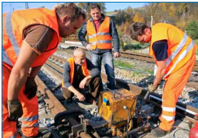
Igora Rusnáka (vľavo), zámočníka koľajových konštrukcií a Tibora Bajčího (vpravo), prevádzkového zámočníka SMSÚ ŽTS ZRS Vrútky sleduje pri robení montovaného izolovaného styku ich vedúci Ing. Dušan Grandtner (v podrepe) a Ing. Jozef Blahovec (druhý sprava), prednosta sekcie ŽTS.
