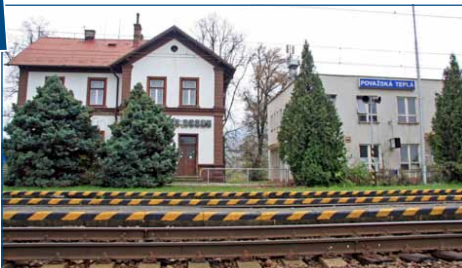
Pôvodná stanica, v ktorej je čakáreň a staničné byty, je datovaná do roku 1903. Novšia budova reléového zariadenia a dopravnej kancelárie slúži od roku 1993.
