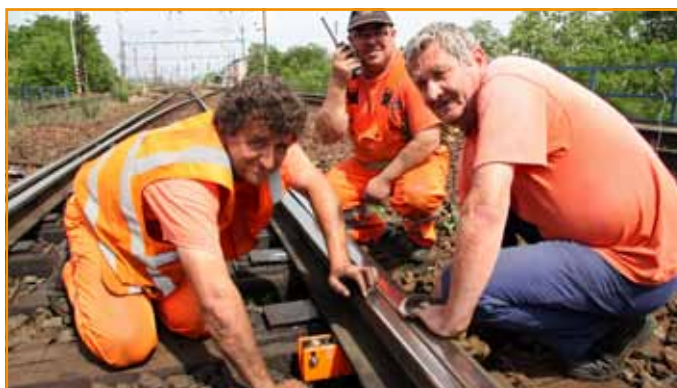
Viliam Mihál, Jozef Hamburg a Ján Filip, zámočníci kolajových konštrukcií z SMSÚ ŽTS TO Bratislava sa s nastavením valčekov na starých výhybkách v ŽST Devínska Nová Ves natrápili podobne, ako mnohí ich kolegovia inde na Slovensku.
