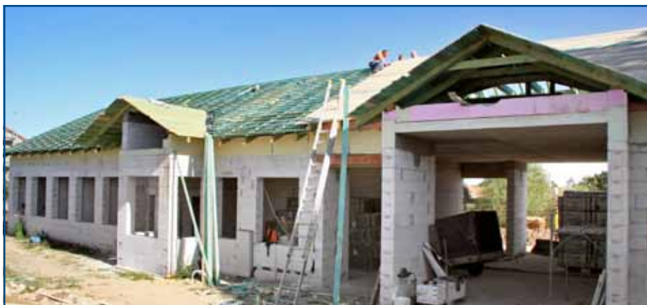
Nová budova by mala byť odovzdaná do užívania v budúcom roku.
