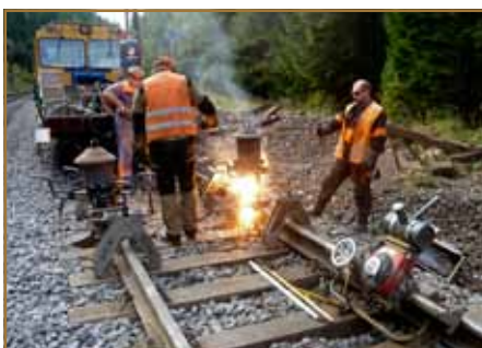
Údržbárske zložky správy ŽTS a OZT OR Žilina spoločne s firmou TSS Grade a.s. intenzívne obnovovali poškodenú druhú traťovú koľaj. Za 4 dni po nehode už bola zjazdná.
