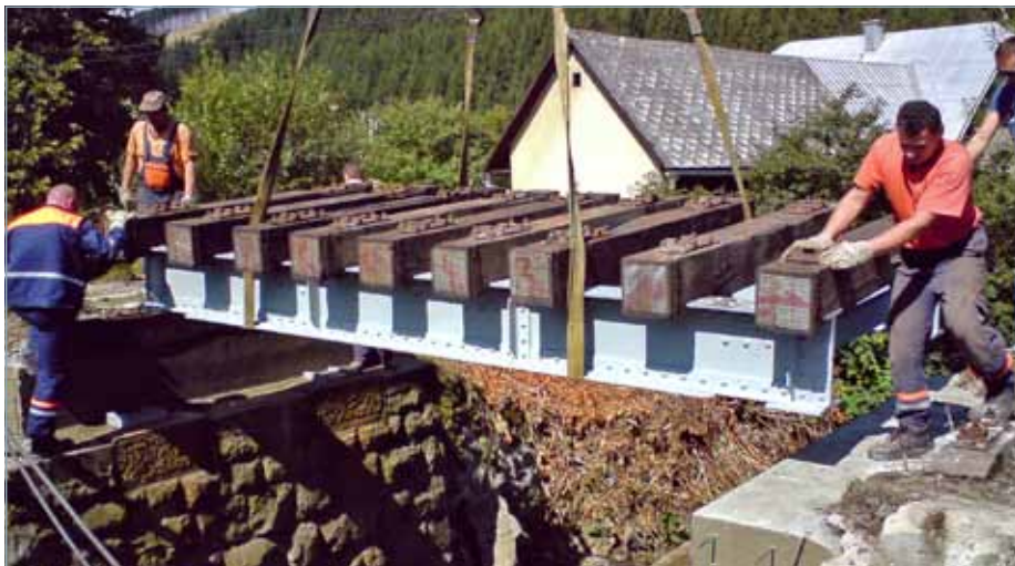
Mostná konštrukcia pri Turzovke dostala špeciálnu farbu s vysokým obsahom zinku.
