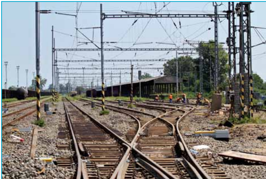
Pohľad na spádovisko, kde rekonštrukcia finišuje.
