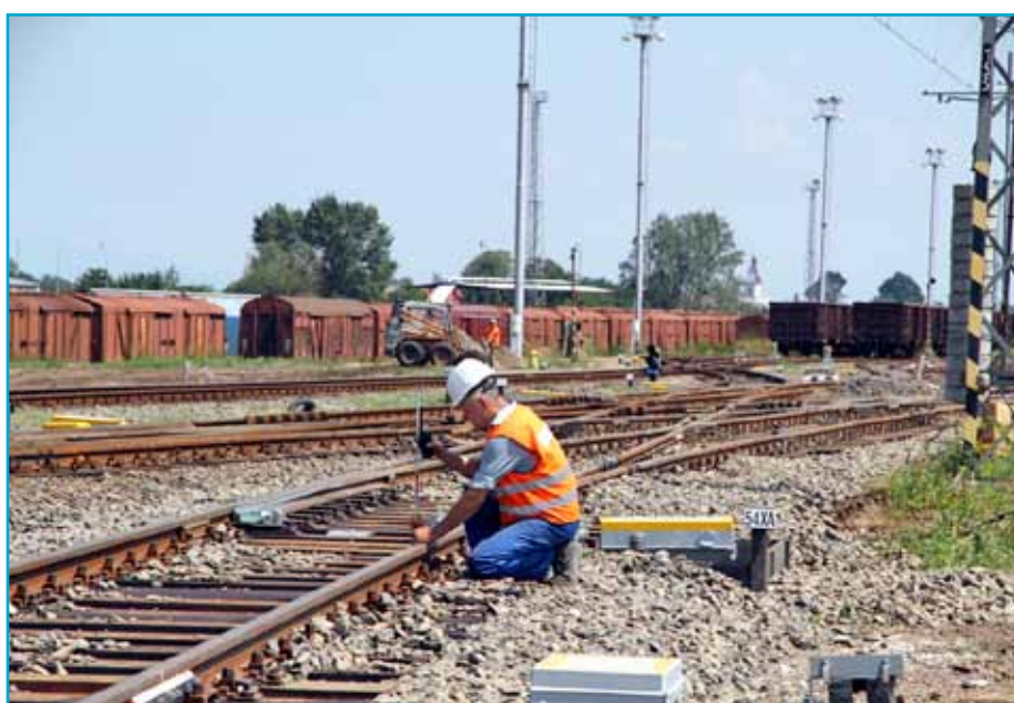
Pracovník vonkajšej obsluhy podbijačky dodávateľskej firmy Železničné stavby a.s. Košice pri práci.
