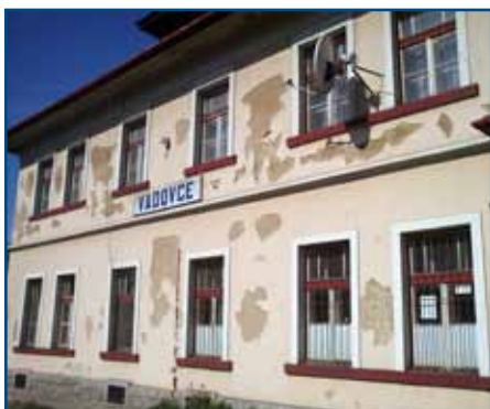
Vaďovce pred rekonštrukciou.
