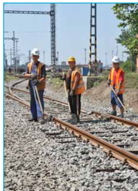
Skupina stavebníkov pri konečnej úprave štrkového lôžka do profilu.
