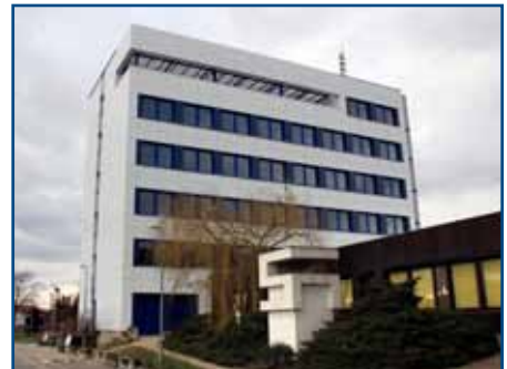
Po rekonštrukcii administratívno-prevádzkovej časti je teraz na rade výpravná časť stanice s vestibulom pre verejnosť.
