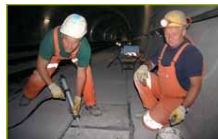
...utesňované boli káblové šachty v tuneli,...
