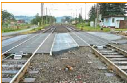
Železničné priecestie po rekonštrukcii, bezprostredne pred sprevádzkovaním.
