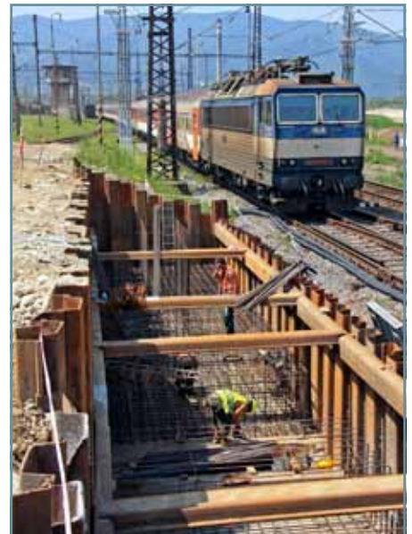
Budovanie piliera v tesnej blízkosti 101. staničnej koľaje si vyžiadalo aj obmedzenie rýchlosti vlakov.
