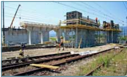
V ŽST Vrútky nákladná stanica vzniká diaľničný privádzač do Martina. Prístupová komunikácia pre stavbárov vedie cez 9 koľají vchodovej skupiny koľajiska.
