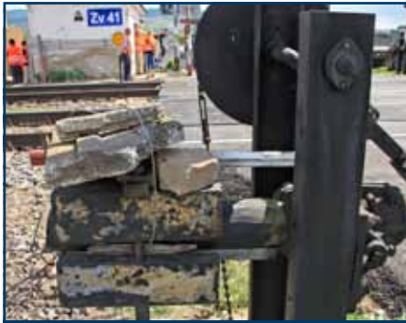
Výmena mechanických závor bola viac než aktuálna. Ako závažie už slúžilo všeličo.
