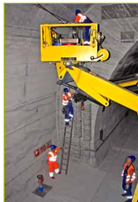
Deň pred sa ešte robili úpravy na trakčnom vedení,...
