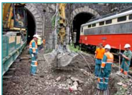
Výluky a stavebné práce pri Lamačských tuneloch znížili priepustnosť trate do Lamača. Niektoré vlaky boli odrieknuté, mnohé meškali.
