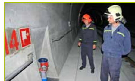
...hasiči testovali suchovodu a kontrolovali hydranty pre prípadný efektívny zásah.
