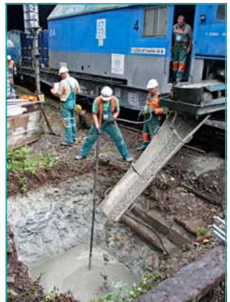
Od apríla do septembra sa v stanici budujú desiatky základov pre trakčné stožiare.
