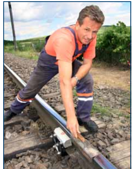
Jaroslav Korytár, návestný majster SMSÚ OZT ZT Slanec simuluje prejazd vlaku posúvaním prípravku ponad snímač osí.
