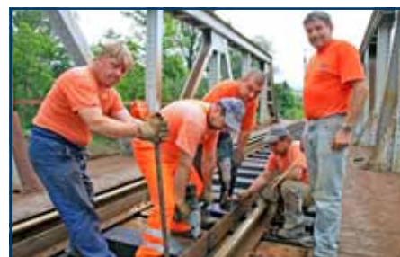
Jedna z namáhavých činností je aj upevňovanie prídržných uholníkov ku koľajnici.
