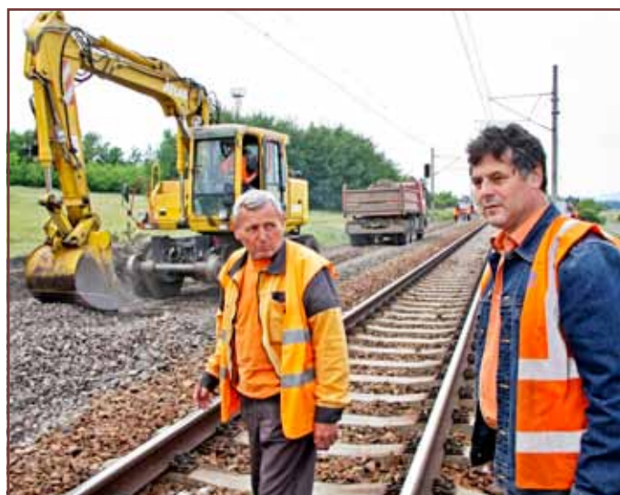
Na priebeh prác dozerá za ŽSR Milan Mráz (napravo), správca železničnej infraštruktúry SMSÚ ŽTS TO Bratislava, z pracoviska v Devínskej Novej Vsi
