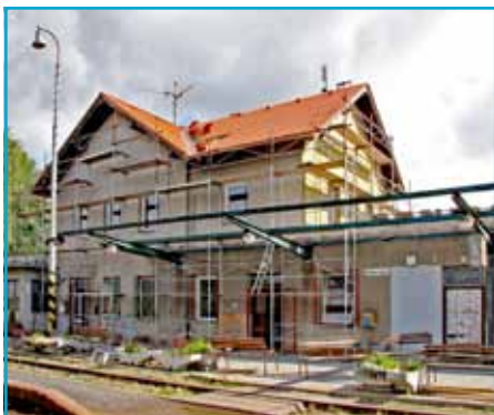
Železničná stanica v Senici prechádza komplexnou obnovou.
