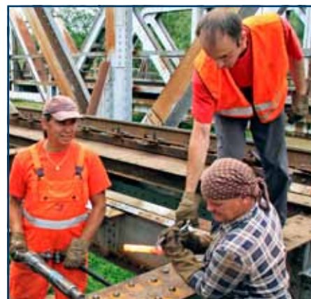
Pri nitovaní hrá čas proti mostárom. Nit sa musí do pripraveného otvoru v mostnej konštrukcii zasunúť ešte riadne rozžeravený.
