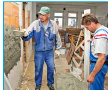
Zmien sa dočkajú aj vnútorné priestory budovy, stavbári neobišli ani čakáreň stanice.
