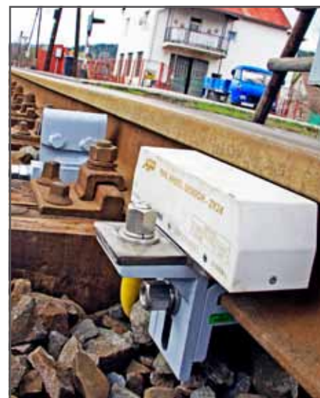
Priecestia v centre Turzovky už neovplyvňuje nasolený sneh. Ovláda ich 10 takýchto snímačov kolies.
