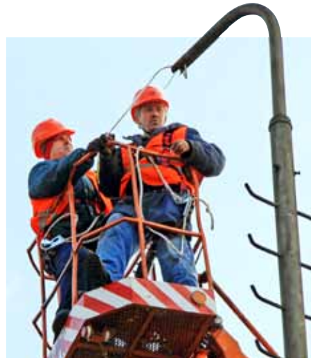
Ešte pred montážou svietidla elektromontéri Petr Vajda a Miroslav Handrk fahajú v stožiare nový prírodný kábel. Inovatívne svietidlo tvoria 4 LED segmenty, ktoré sú samostatne napájané. Ich selektívnym vypnutím, napríklad v dopravných prestávkach, sa zníži intenzita osvetlenia aj odber elektrickej energie.
