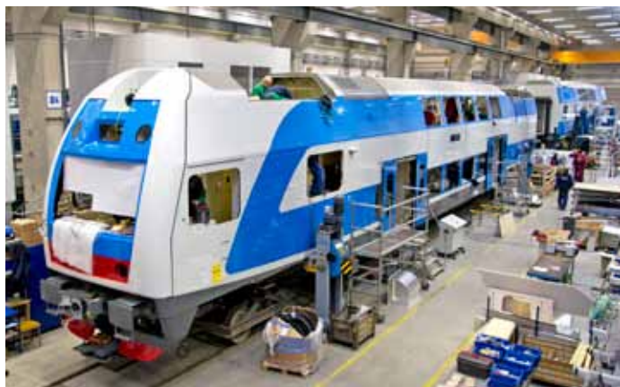
Skríňa motorového vozňa poschodovej jednotky, vyrobená z veľkoplošných hliníkových profilov v ostravskej spoločnosti ŠKODA Vagónka, je v hale plzenskej Škodovky kompletizovaná o elektroinštaláciu, výzbroj a interiér.
