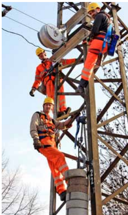
Pokiaľ elektromontéri Marián Smotrila a Vladimír Hricko pripeňovali kotevný systém Tensorex, elektromontér Milan Rožár (dole) demontoval nepotrebné závažie pôvodného napínacieho zariadenia.
