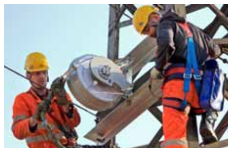
Bezúdržbový kotevný systém Tensorex od firmy PFISTERER upeňovali elektromontéri Marián Smotrila a Vladimír Hricko z SMSÚ EE TV Poprad. Na správnu montáž aj nastavenie dozeral zástupca dodávateľa, ktorý pricestoval až z Milána.
