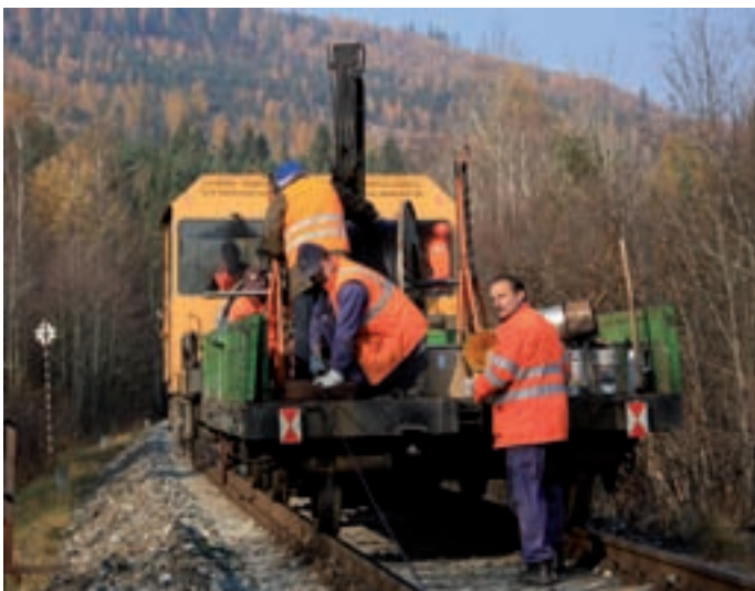
Kábel sa pri pokladaní odvíjal z bubna umiestnenom na vozíku.
