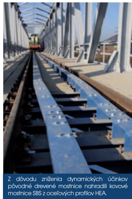
Počas statickej zaťažovacej skúšky postávali dve dvojice hnacích vozidiel radu 771 a 183 desiatky minút nad hladinou Váhu.
