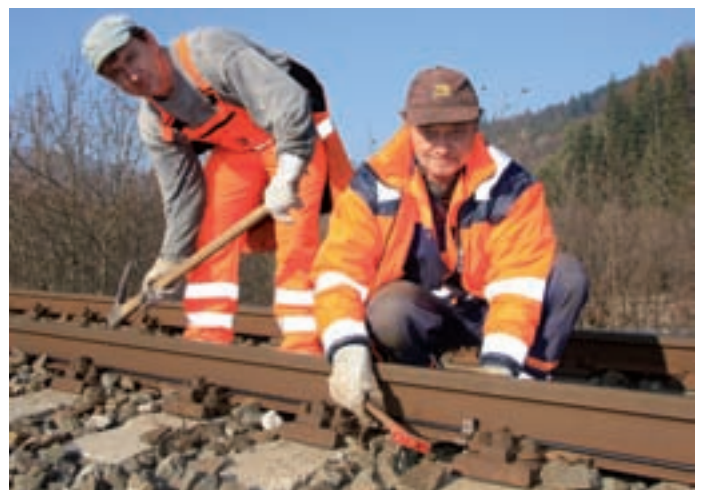
Jednoduchosť uchytenia kábla pomocou oceľových spôn predviedli Miroslav Melega a Štefan Šmida z SMSÚ OZT SO Spišská Nová Ves. Ich tempo bolo naozaj rýchle.
