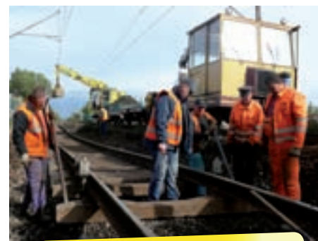
Polohu podvalov v koľaji upravovali traťoví robotníci z SMSÚ ŽTS TO Bratislava.
