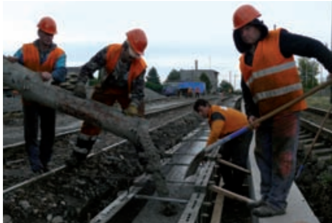
Stanice aj zastávky dostanú nové nástupištia. Vyrastú na betónových základoch, povrch nástupíšť pozostáva z konzolových dosiek a zámkovej dlažby. Ich súčasťou sú aj vodiace a varovné pruhy pre nevidiacich a slabozrakých.
