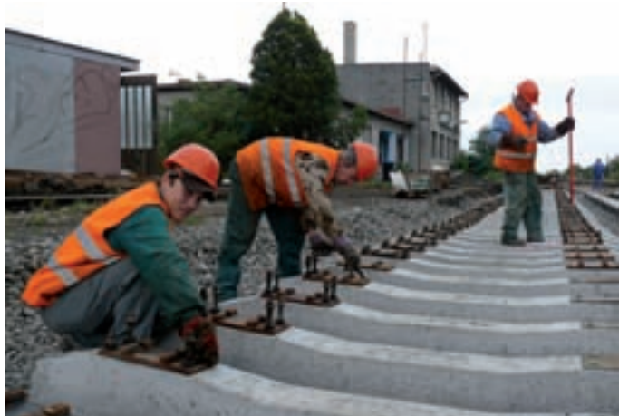
Na viacerých miestach bolo vymenené štrkové lôžko, vytrhané výhybky nahradili koľajové polia, práce v koľajiskách sa nezaobišli bez smerovej a výškovej úpravy koľají.
