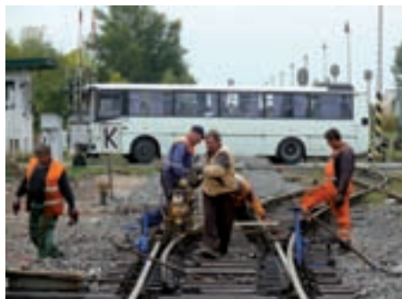
Výhybky v staniách boli opravené z regenerovaných materiálov, vymenili sa vyhnité podvaly, samovraty nahradili výmeny s elektromotorickými prestavníkmi.
