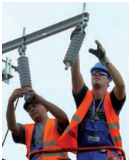
Miroslav Horváth a Daniel Dzurenda, montéri firmy ELTRA s.r.o., počas výmeny izolátorov zároveň sledovali, aby nedošlo k zmene geometrie trakčného vedenia.
