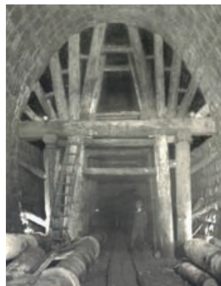
Ťažká výdrevka pri stavbe tunela Pod Poľanou.
