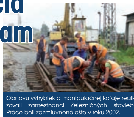
Traťoví robotníci z SMSÚ ŽTS TO Nové Mesto nad Váhom rovnomerne rozkladali nasypaný štrk k podvalom výhybky.
