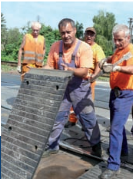
Komplexnú rekonštrukciu realizujú ŽSR z vlastných zdrojov, práce vykonávajú naši zamestnanci, iba s výnimkou asfaltovania a montáže priecestnej konštrukcie STRAIL, ktorú rieši firma D.I.S., a.s. Bratislava.
