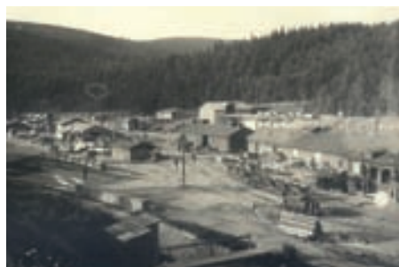
Vrbovecké nádvorie pri stavbe tunela pod Poľanou.
