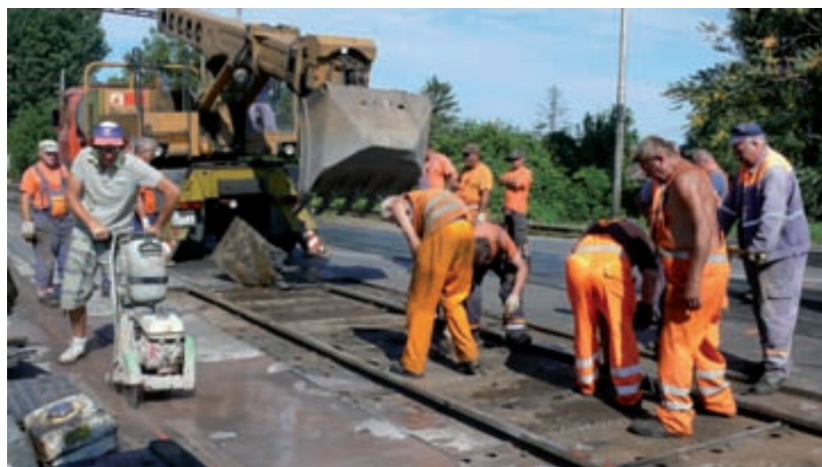
Komplexnú rekonštrukciu realizujú ŽSR z vlastných zdrojov, práce vykonávajú naši zamestnanci, iba s výnimkou asfaltovania a montáže priecestnej konštrukcie STRAIL, ktorú rieši firma D.I.S., a.s. Bratislava.
