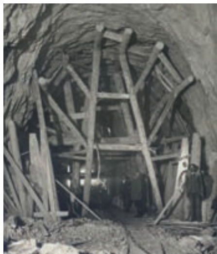
Ľahká výdrevka pri stavbe Čachtického tunela.
