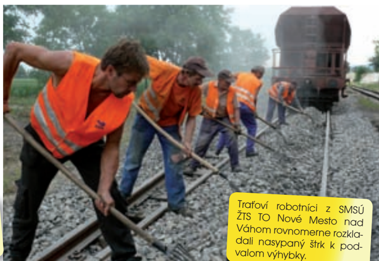
Juraj Miškech, Dušan Procházka a Ivan Jurák pracovali na oprave rozchodu výhybky a upevňovaní koľajnic k podvalom.
