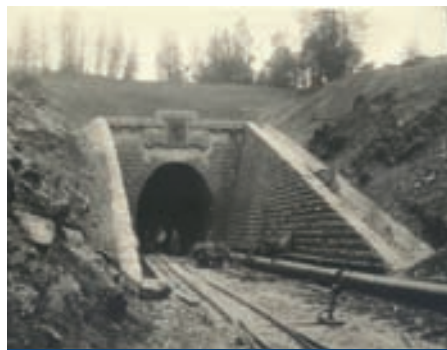
Portál tunela Pod Poľanou počas výstavby.
