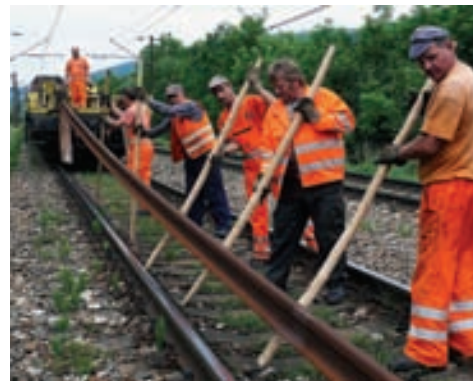
Zohratosť chlapov sa prejavila aj pri ukladaní nových koľajnicových pásov zo súpravy SDK 2.
