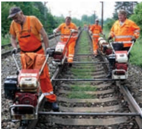
Traťoví robotníci, zľava Alojz Badošek, Martin Behro, Peter Hamšík, Miroslav Ofúkaný zachytení pri uvoľňovaní matíc motorovými zaťahovačkami.
