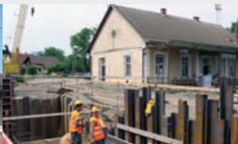
Prí oboch traťových koľajach budú nové nástupištia, ktoré bude spájať novobudovaný podchod.
