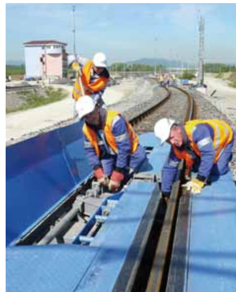
Namontované sú už aj koľajové brzdy, ktoré sú neodmysliteľnou súčasťou spádoviska.
