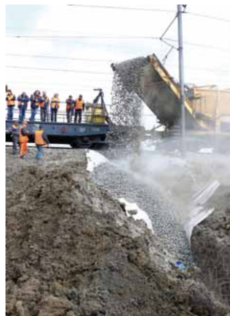
Po uložení odvodňovacej rúry na dno výkopu traťováci zasypali rebro štrkom. Počas sanačných prác použili približne 2 500 ton štrku.
