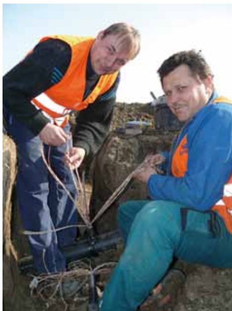
Káble síce boli prekladané dodávateľským spôsobom, ale zapotili sa aj košickí kabelári. Napriek čulému stavebnému ruchu na svoju príležitosť striehli aj dlhoprstí. Radostlav Papcun a Ladislav Majerník z SMÚ OZT KT Košice odstraňujú následky krádeže kábla zabezpečovacieho zariadenia.
