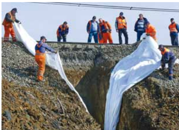
Výkopy kónusového tvaru, s hĺbkou až 9 metrov, zamestnanci SMÚ ŽTS TO Trebišov najskôr vystlali geotextíliou.
