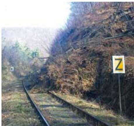
Zemina sa medzi koľajnicami ocitla po spadnutí svahu nad traťou na takmer 30 metroch.
