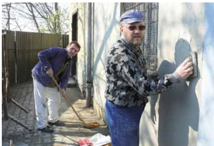
Do opráv bolo zahrnuté aj vynovenie fasády staničnej budovy.
