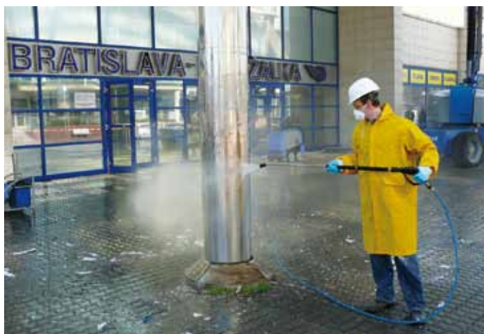
Na odstránenie starých plagátov postačil aj tlak vody.
