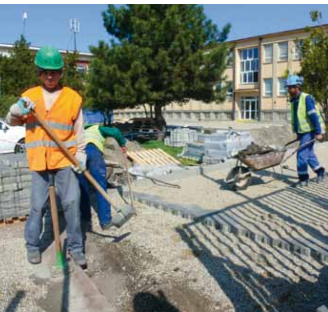
Revitalizovala sa tiež vonkajšia plocha, na ktorej vznikli nové parkovacie miesta.
