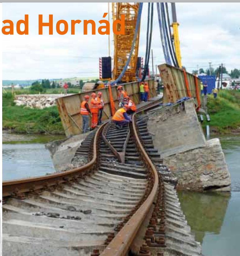
Koľaj vísajúca nad hladinou Hornádu, naklonená opora a skrútený most – taká bola bilancia povodne v Spišských Vlachoch.
