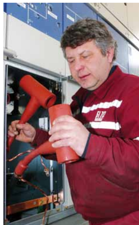
Koncovky káblov v rukách Róberta Mikulu z firmy ELZA, a.s., svedčia o veľkosti prúdov vychádzajúcich z rozvodne.
