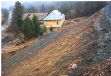
Priečne rebra v svahu prispeli k jeho spevneniu. Rekonštrukčné práce boli v režii ÚŽI Zvolen, SMÚ TO Jesenské na požiadavku správcu OR Košice, AO Zvolen.
