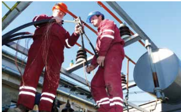
Zamestnanci dodávateľa Miroslav Hrušík a Rastislav Čička pripájajú prírodný kábel k trakčnému transformátoru.
