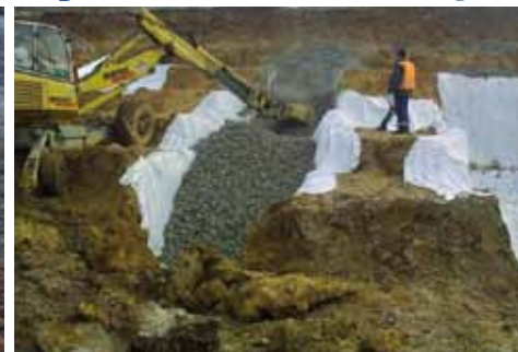
Priečne rebra v svahu prispeli k jeho spevneniu. Rekonštrukčné práce boli v režii ÚŽI Zvolen, SMÚ TO Jesenské na požiadavku správcu OR Košice, AO Zvolen.
