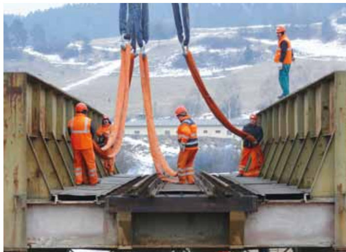
Na rad prichádza presun pôvodného mosta. Aj ten treba bezpečne pripnúť.
