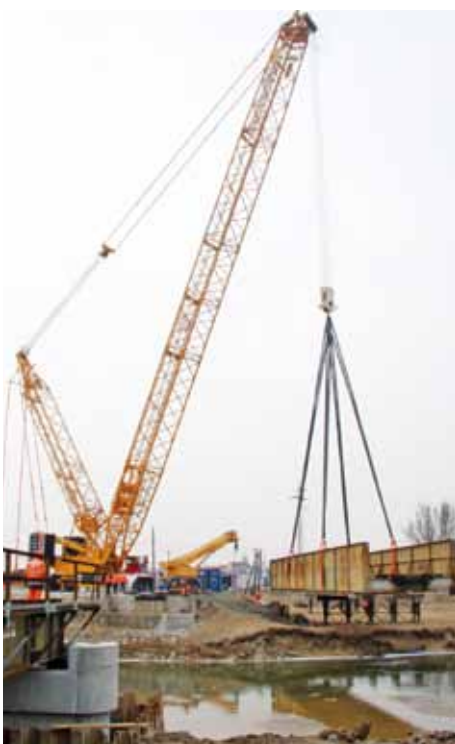
Vyššie 100-tonová konštrukcia sa už presúva nad hladinou Hornádu k obnoveným podperám.
