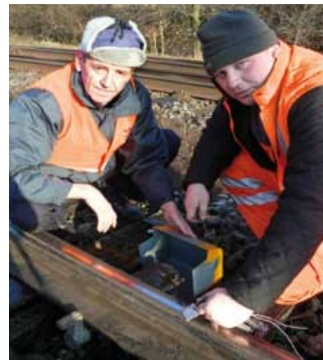
Návěstní majstri z SMÚ OZT ZT Nové Zámky (zľava) Imrich Pathó a Ladislav Merész uzamkajú jazyky výhybiek výmenovými zámkami.
