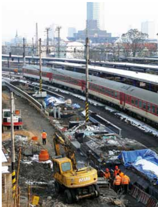
Na rekonštrukciu 5. nástupišťa bola schválená finančná čiastka vo výške takmer 2,2 milióna eur.
