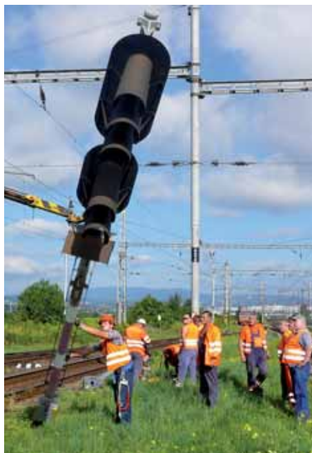
Staré návěstidlo sovietskeho vzoru doslúžilo, o chvíľu sa ocitne v tráve. Na jeho mieste čoskoro bude stáť nové.
