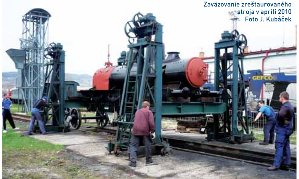
Inštalácia rušňa s hmotnosťou 22t na pomník Foto M. Tunega
