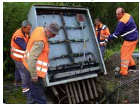
Pôvodná reléová skriňa autobloku práve došla, miesto prenecháva svojej novej „kolegyni“.
