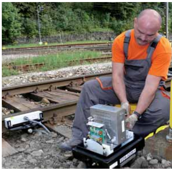
Do poruchových „čujnikov“ montujú novú elektroniku pracovníci poľského dodávateľa.
