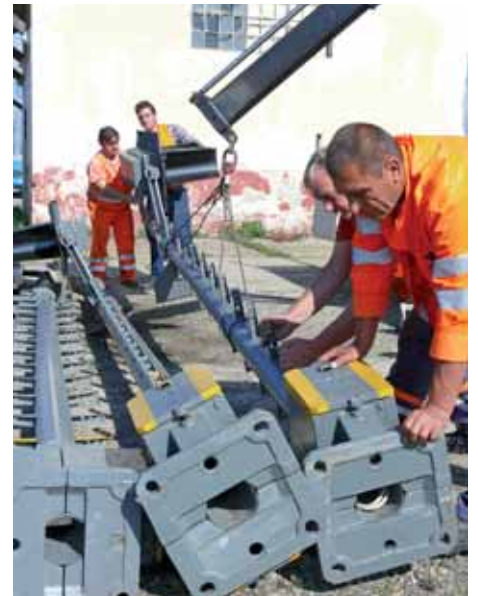
Nové návěstidlá sú už pripravené, ich výmena sa môže začať.
