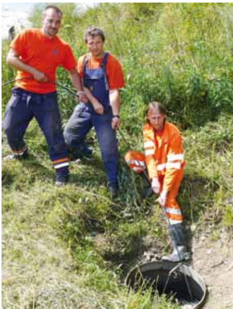
Na jednej strane optokábel tlačí do chráničky zafukovačka, na druhej strane mu ťahajú zo šachty pomáhajú Juraj Danovský, Jozef Hnilický, Viliam Hančík (zľava), návestní majstri z SMÚ OZT KT Žilina.
