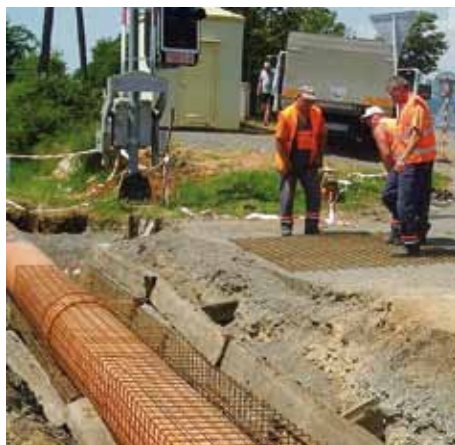
Odvodnenie priecestia bolo do jeho rekonštrukcie prakticky nefunkčné. Celú opravu priecestia riešili zamestnanci ÚŽI Zvolen.
