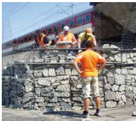
Oporný múr z drôtokošov meria asi 80 m a je vysoký 3 m. Výška oporného múru bola navrhnutá s ohľadom na výšku storočnej vody aj s polmetrovou rezervou.
