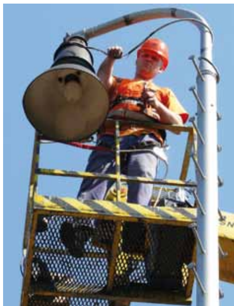
Zatiaľ čo Vladimír Žerovnický z plošiny odpája prívodný kábel a demontuje staré svietidlo,...
