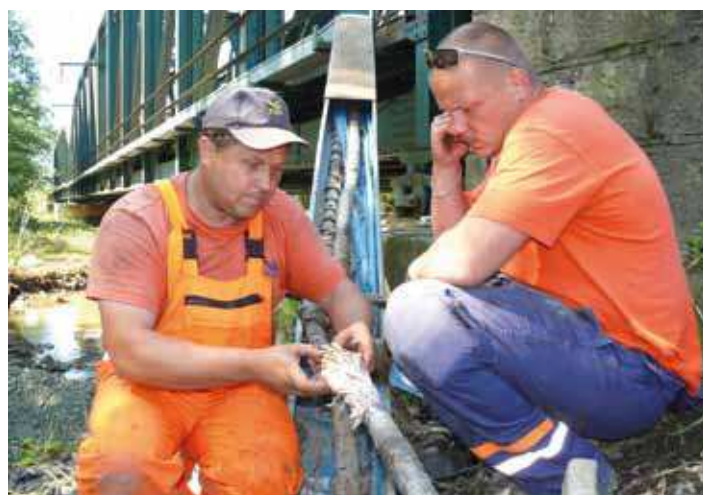
Kábelári lokalizovali medzi Košicami a Kysakom až 16 porúch na diaľkových kábloch, zapríčinených vodou a bludnými elektrickými prúdmi. Pri oprave jednej z nich sme pri železničnom moste ponad rieku Hornád zastihli aj Ladislava Majerníka a Matúša Hlavu z SMÚ OZT KT Košice.
