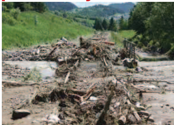
Prudké dažde spustošili aj trať pri Starej Ľubovni. Naplaveniny, najmä časti drevín a kamene, sa nahromadili nielen v koryte miestneho potoka, ale aj vo vtokovej a odtočkovej časti priepustu, preto si privalová voda našla novú cestu cez koľaje.
