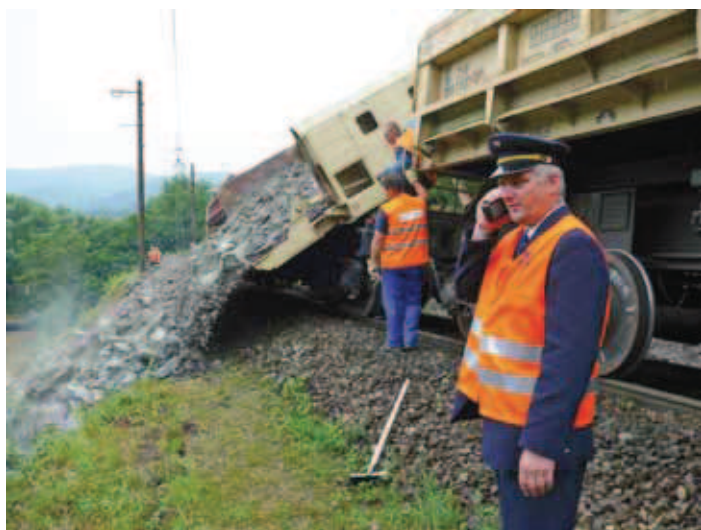
Prednosta železničnej stanice v Kysaku Ing. Peter Tabačko priamo na trati, kde došlo k mimoriadnej udalosti, riadil a usmerňoval postup prác a dopravu smerom do Prešova.
