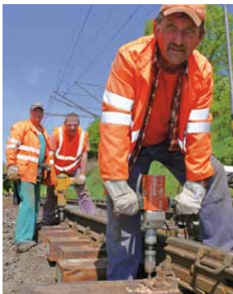
Traťoví robotníci, zľava Jozef Tanáč, Stanislav Hesek a Juraj Balla, pracujúci na prichytení nových priečných podvalov.
