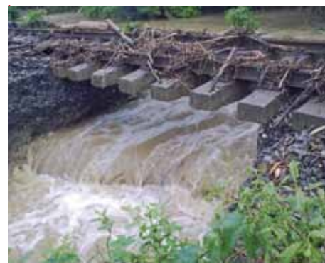
Rozbúrený vodný živel strhol aj železničné teleso.
