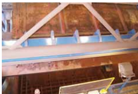
Prekládku z vozňov širokého rozchodu je možné realizovať priamo do vozňov normálneho rozchodu, s možnosťou nepriamej prekládky pomocou preskladenia substrátu pod samotnou III. vysokou rampou po celej jej dĺžke. Následne sa zo skládky substrát pomocou rýpadiel naloží do vozňov normálneho rozchodu.
