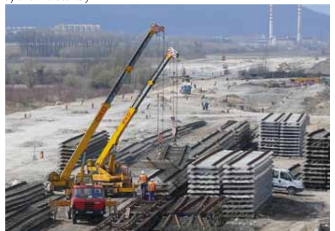
Na obnovu 35 kilometrov staničných koľají sa musia na montážnych základniach pripraviť stovky koľajových polí.
