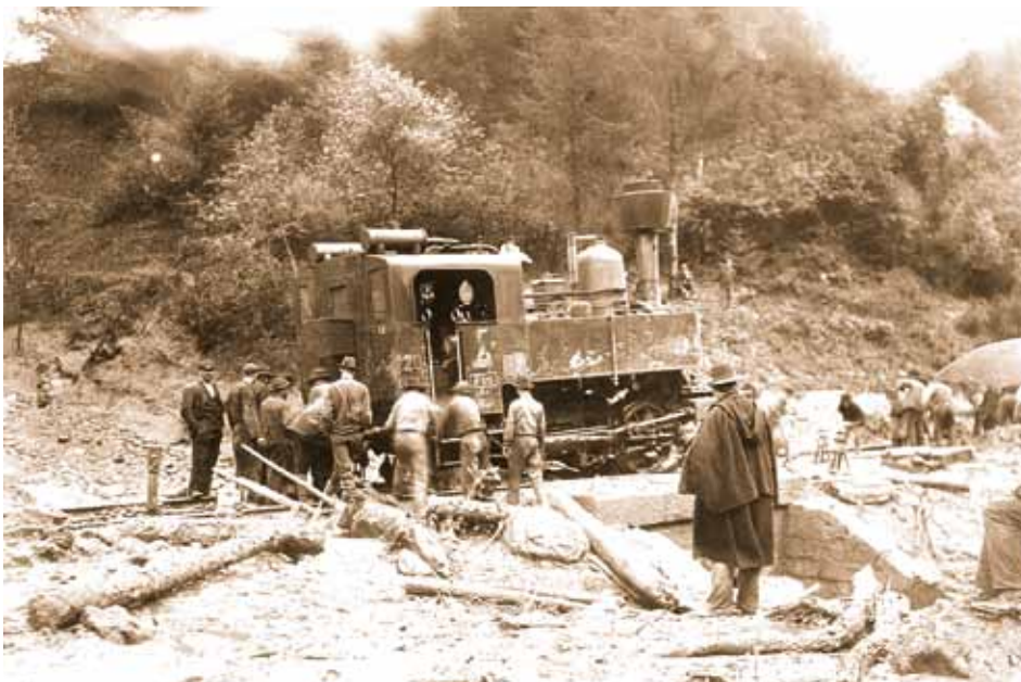
Fotografia zo začiatku 20. storočia zobrazujúca nákoľajovanie rušňa pomocou hřebeňových zdvihákov.
