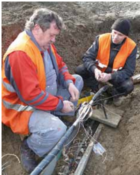
Spájanie žíl si vyžaduje maximálne sústreďenie, aby sa vodiče vzájomne nepoplietli.
