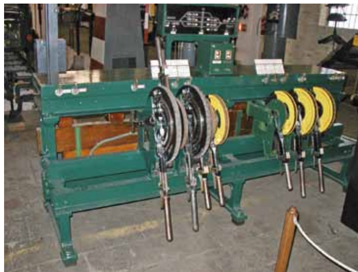
Toto ústredné stavadlo slúžilo v stanici Čremošné.
