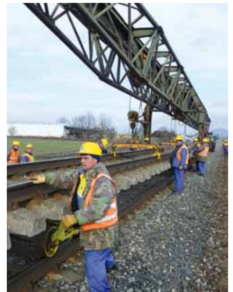
Železničné stavby, a.s., za týždeň vytrhali koľajové polia z 2. traťovej koľaje medzi Trenčianskou Teplou a Dubnicou nad Váhom.
