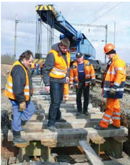
Kladenie mostných provizórií, na ktorom sa podieľali obidva mostné obvody, obmedzilo vlakové spojenia aj medzi Trenčianskou Teplou a Nemšovou.
