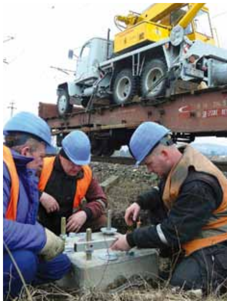
Zamestnanci zhotoviteľskej firmy Eltra s.r.o. sa už sústredili na obnovu trolejového vedenia.
