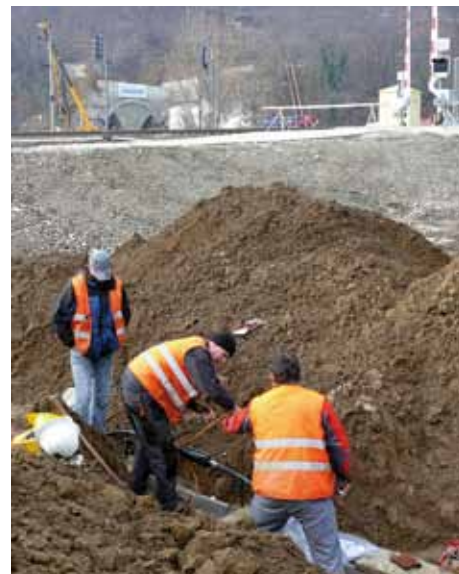
Káble sa spájajú v náročných a stiesnených podmienkach 80-centimetrového výkopu, častokrát aj v chladnom počasí.
