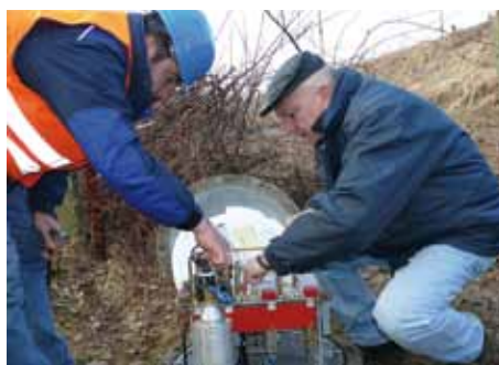
Zľava Ing. Jozef Krivý, koordinátor SMS OZT KT Trenčianska Teplá, a Stanislav Milan, stavbyvedúci zo zhotoviteľskej firmy Beta-mont, pred výlukou koaxiálneho vedenia od-pájajú zo zosilňovačov žily kábla.
