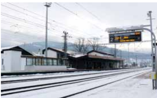
V Krásne nad Kysucou je vybudovaných 6 km koľají, trakčné vedenie v dĺžke 7 800 m, zabezpečovacie zariadenie ESA 11 a pre cestujúcich nástupišťa s podchodom a informačný systém.
