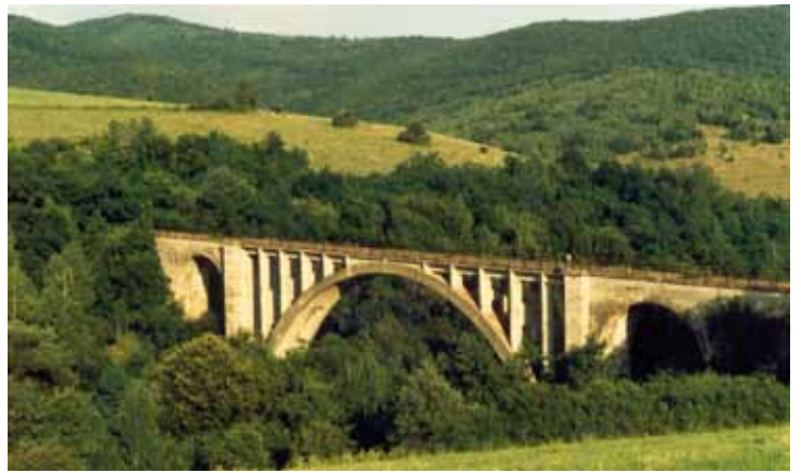
Železobetónový klenutý most na nedostavanej železnici Slavošovce – Lubeník (prvá polovica 40. rokov 20. stor.). Foto: P. Kallo
