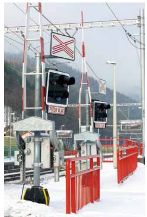
V stavebnom úseku 3 bolo zrekonštruovaných 5 priecestí a 5 železničných mostov. Vybudovaných je 7080 m dvojkoľajnej trate, trakčné vedenie v dĺžke 18 750 m, či 3-značkový elektronický obojsmerný automatický blok.
