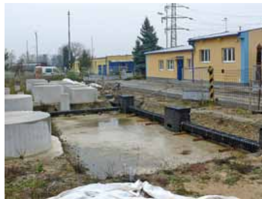
V areáli TNS Galanta sú nachádzajú aj základy novobudovaného filtračno – kompenzačného zariadenia. Má slúžiť na filtráciu vyšších harmonických frekvencií v napätí a kompenzáciu jalového výkonu v transformátoroch. Stavba však bola pozastavená v jeseni 2008.
