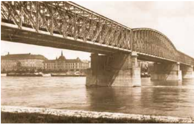
Most cez Dunaj v Bratislave s kombináciou jedného poloparabolického a niekoľkých priamopásových nosníkov (1890).
