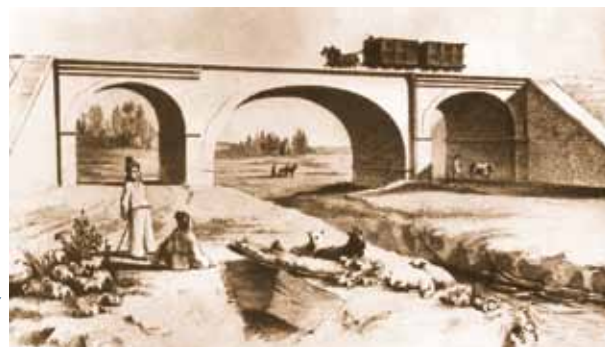
Klenutý most na koneskej železnici Bratislava – Trnava (40. roky 19. stor.)
