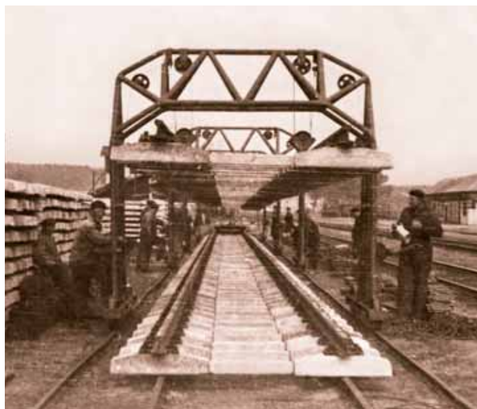
Žeriavy Vošahlík pri manipulácii so zmontovanými koľajovými poliami.
