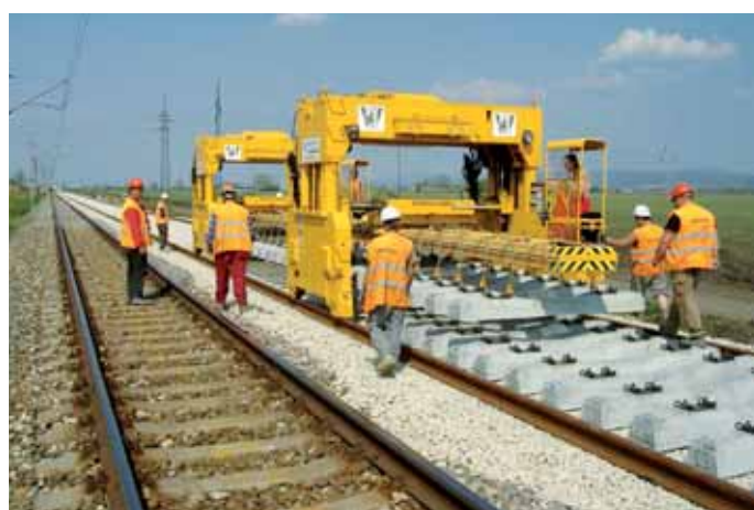
Technológia Donelli - dva portálové žeriavy PTH 350 spojené traverzou premiestňujú podvaly na miesto určenia. Foto: Ing Peter BADO
