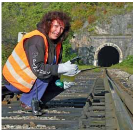
Skôr, ako sa výhybka pri Jablonovskom tuneli začala po dvoch rokoch opäť používať, premastila ju dozorkyňa výhybiek Helena Iglaiová.
