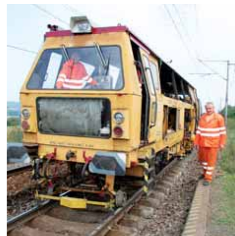
Traťový stroj ASPK400 pri úprave smeru a výšky po čistení
