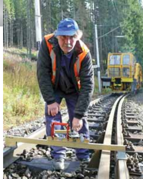
Ján Jancík, traťový robotník z SMÚ ŽTS TO Spišská Nová Ves, kontroluje po podbití prevýšenie koľajníc.
