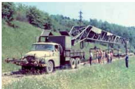
Žeriavy PKP 25/20 a 25/20/2 pracujú na stavbách železničných tratí dodnes.
