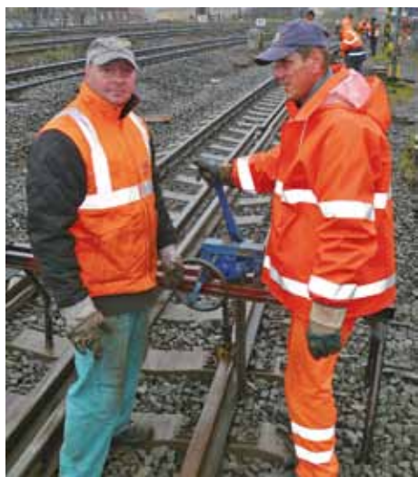
Jozef Tanáč a Martin Škrabák (zľava), jedna z dvojíc traťových robotníkov SMÚ ŽTS TO Bratislava, ktoré s pomocou koľajových žeriavikov vymieňali koľajnicový pás.
