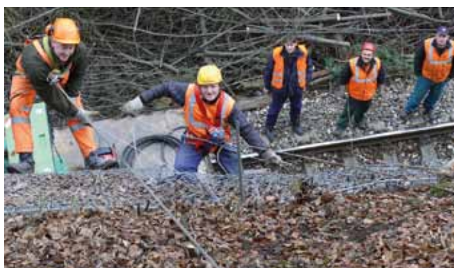
Na upevnenie zaistovacej siete v 15-metrovej výške je nevyhnutný horolezecký výcvik. Tunelárov (zľava) Lukáša Slávika a Andreja Hrízu (aj na obálke) usmerňovali kolegovia ten zospodu, z trate.
