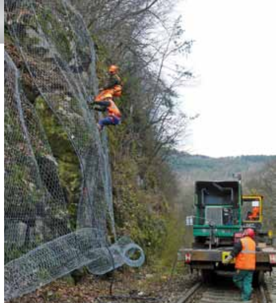
Počas traťových výluk tunelári natiahli na svahu takmer 400 m 2 zaistovacej siete.
