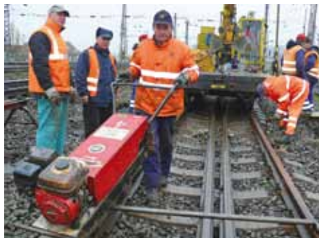
Majster Ľudvík Rigó (druhý zľava) riadil rekonštrukčné práce vrátane strojného dotahovania upevňovadiel v podaní Milana Vrábela.
