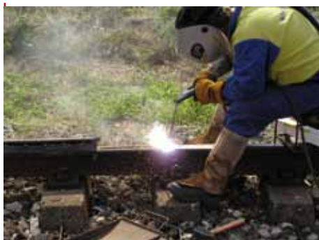
Zamestnanec firmy MÁV THERMIT KFT pri navaraní antikorového návaru.
