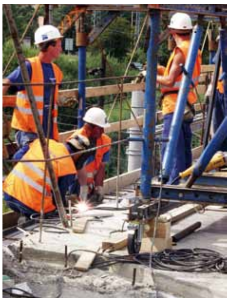
V týchto dňoch sa na moste nad železničnou traťou pracuje v plnom nasadení...
