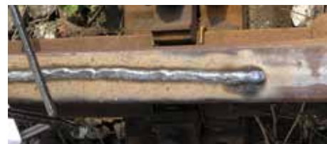
Takto vyzere detail antikorového návaru.
