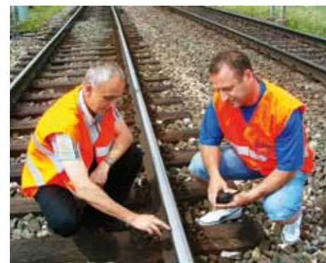
Vedúci AO Spišská Nová Ves Ing. R. Novák (vľavo) kontroluje zmeny na koľajnici po strojnóm brúsení. Pri ňom je zástupca firmy RRB Slovakia, s.r.o., Tibor Roman, ktorý brúsiace vozidlo sprevádza so svojim tímom.
