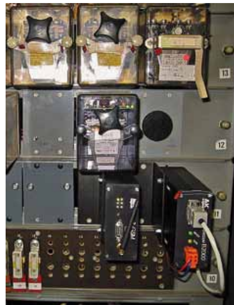
Záznamové zariadenie v prevádzke, namontované na stojan s relé.
