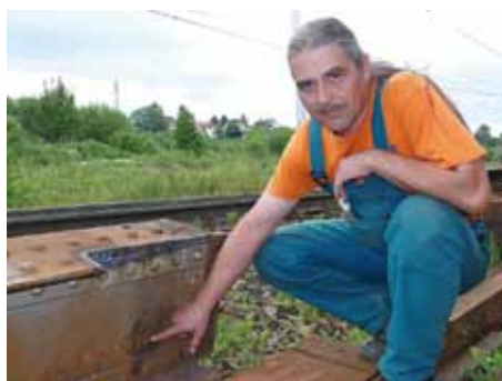
Peter Ondrička, majster čaty zo strediska Žilina, ukazuje, ako korózia oslabila stojňu pozdĺžnika.
