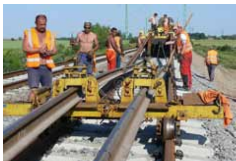
Strojník Jozef Varga (prvý zľava) riadi od vymieňaceho vozíka prácu manipulátora pri zosúvaní koľajnicových pásov, ale aj pracovníkov dodávateľa pri výmene inventárnych koľajnic za koľajnice UIC60.
