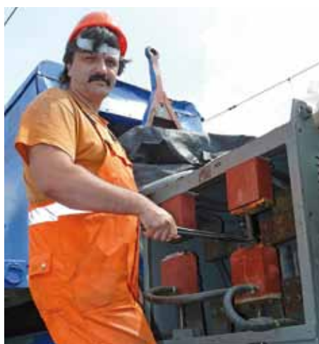
Nit v kliešťach, ktoré drží Dušan Fraňo, majster čaty zo strediska Bratislava, sa v elektrickej ohrievačke rozžeraví na teplotu 1200 °C. Potom sa musí rýchlo premiestniť na miesto nitovania.
