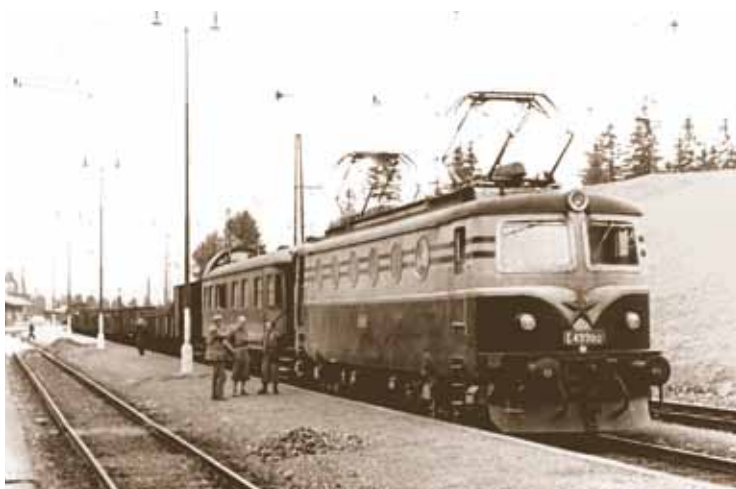
Skúšobný vlak ťahaný novým elektrickým rušňom E 499.012 na elektrifikovanej „štrbskej rampe“ v roku 1955.
