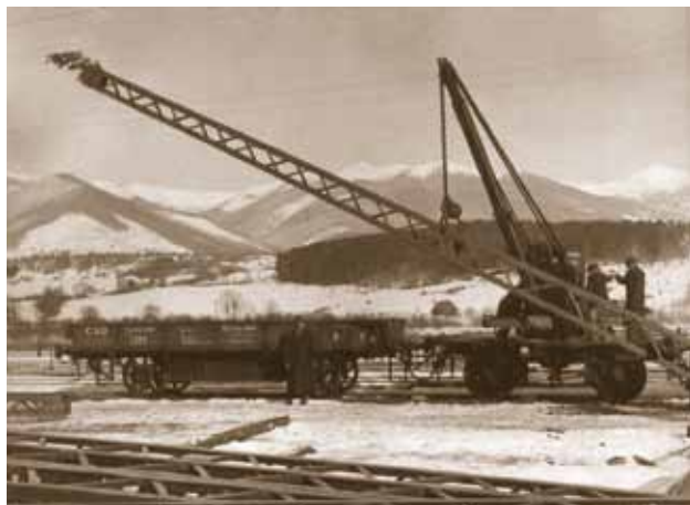
Z prevádzkových i ekonomických dôvodov bol ako prvý elektrifikovaný úsek Žilina – Spišská Nová Ves. Na úseku Žilina – Vrútky, ktorý bol zvolený ako začiatok elektrifikácie, sa stavebné práce začali 12. 6. 1949 slávnostným výkopom v železničnej stanici Varín.
