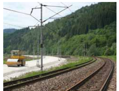
Zvýšenie traťovej rýchlosti si vyžaduje aj čiastočné vyrovnanie traťového oblúka medzi Ochodnicou a Dunajovom.
