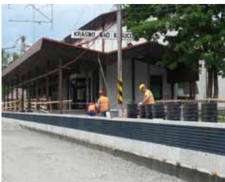
Pred staničnou budovou už vyrástla hrana prvého nástupišťa.
