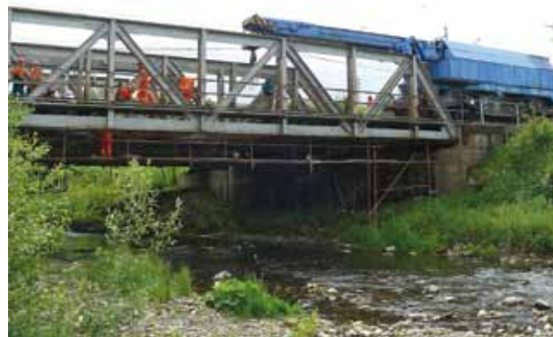
Pozdĺžniky nitovaného mosta v 1. traťovej koľaji trate Žilina–Mosty u Jablunkova už boli koróziou natoľko oslabené, že ich Mostný obvod Bratislava musel vymeniť.
