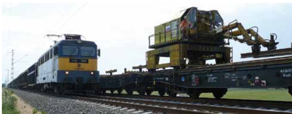
Pracovalo sa za plnej prevádzky. Kým sa na jednej koľaji pohybovala súprava SDK II, po druhej jazdili maďarské vlakové súpravy.
