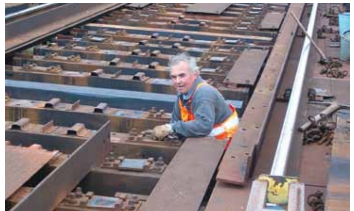
Montér ocelových konštrukcií MO Košice Jaroslav Kurta si pri doťahovaní mostnicovej skrutky musel zvoliť nezvyčajnú polohu.
