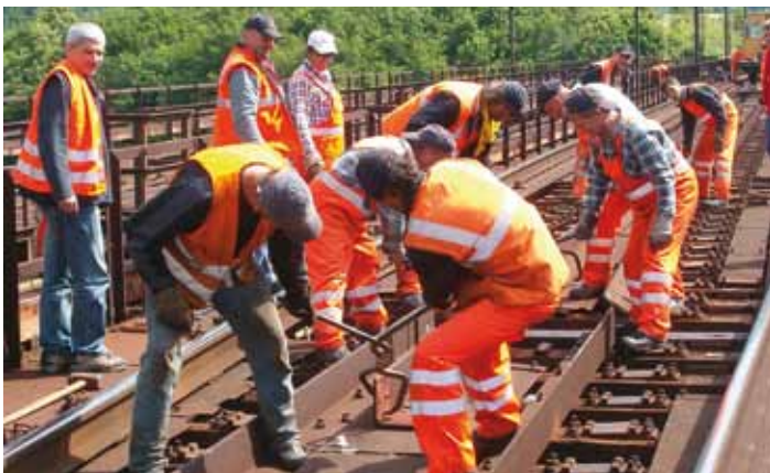
Osadzovanie poistných uholníkov si vyžaduje súhru i fyzickú zdatnosť.
