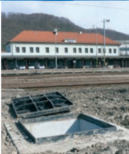
Káblody a šachty museli byť hotové ako prvé, aby sa mohli ťahať nové kábové rozvody elektronického stavadla.
