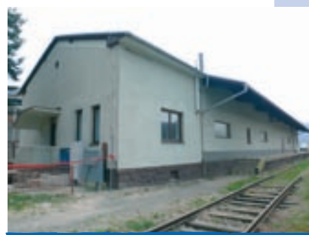
Paradoxne, tak ako stojany s relé, ani technika nového elektronického stavadla nebude umiestnená v staničnej budove. Priestory pre elektroniku sa nachádzajú v zrekonštruovanej budove bývalého skladu.
