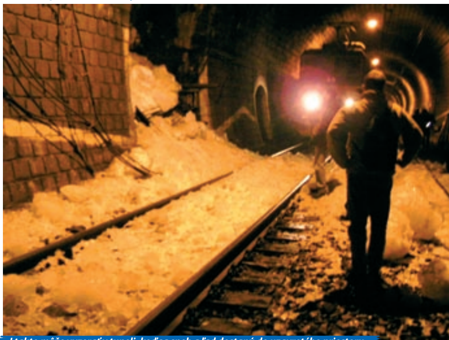
I takto môže vyzerať v tuneli, keď sa sneh a ľad dostanú do uzavretého priestoru.
