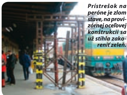
Časť liatinovej hlavice na podpornom stĺpe sa už dávno odlomila, výpravca sa ledva stihol uhnúť.
