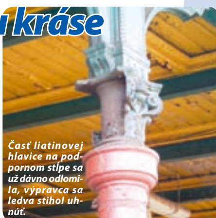
Prístrešok na peróne je zlom stave, na provizórnej ocelevej konštrukcii sa už stihla zakoreniti zelen.
