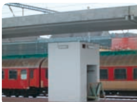
Výťahové šachty sa dokončujú v týchto dňoch, dve sú určené na batožiny a vozíky a dve pre osoby.
