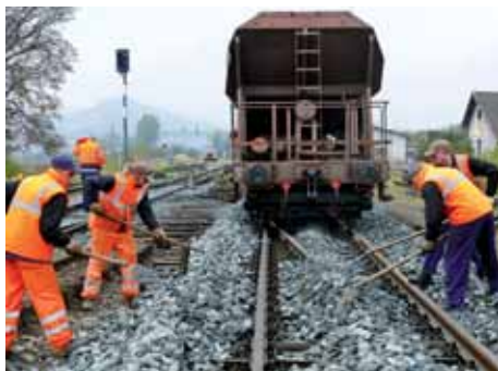
Položené výhybky je potrebné riadne zaštrkovať a následne aj niekoľkokrát podbiť. Až tak po nich môžu prechádzať vlaky s maximálnou traťovou rýchlosťou.
