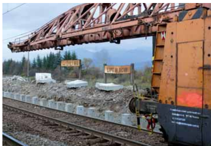
Počas obnovy koľaje sa zmení aj vzhľad príslušného nástupištia na zastávke v Liptovských Vlchoch. Pôvodný asfaltový povrch nahradí zámková dlažba.
