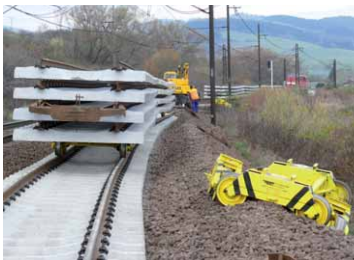
Drevené podvaly v 2. traťovej koľaji nahradila dodávateľská spoločnosť koľajovými poliami s betónovými podvalmi.
