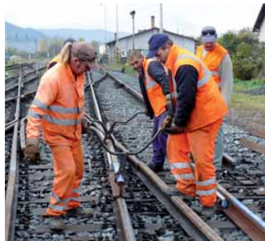
Napriek chladnejšiemu jesennému dňu sa chlapi pod vedením Karola Zemana, vedúceho prevádzky Turna nad Bodvou, riadne zapotili aj pri prenášaní a osadzovaní montovaných izolovaných stykov.
