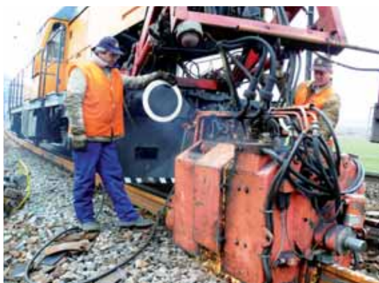
Zvárači Karol Tomka a Peter Babín (aj na obálke) z SMÚ ŽTS MDS Nové Zámky predvádzali svoju zručnosť počas elektrokontaktného odtavovacieho stykového zvarovania so zväracím strojom PRSM4.
