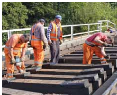
Na oblúkovom moste museli košickí mostári upraviť 88 nových mostníc, aby koľaj mala potrebné prevýšenie.
