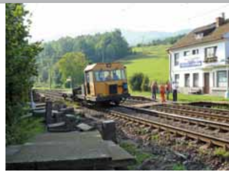
Znížením nivelety koľaje sa muselo prebudovať aj nástupište na zastávke Veľká Lodina.
