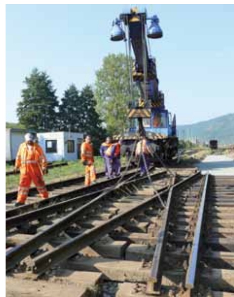
Ako skladanie puzzle. Každá časť koľajovej spojky má svoje presné miesto, na ktoré ich s milimetrovou presnosťou ukladá koľajový žeriov EDK300W z SMÚ MDS Spišská Nová Ves.
