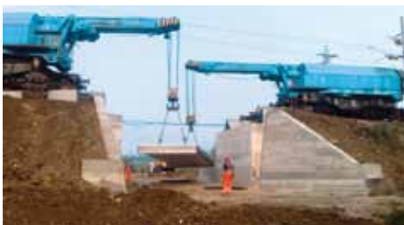
Na osadzovanie železobetónových prefabrikátov použili mostári dva koľajové žeriavy EDK 750.
