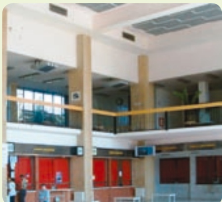
Prijímacia budova železničnej stanice v Nových Zámkoch sa začala stavať v novembri 1966 a bola ukončená až o šesť rokov. Architektonický návrh vyšiel z ateliéru Ing. arch. Fifíka.
