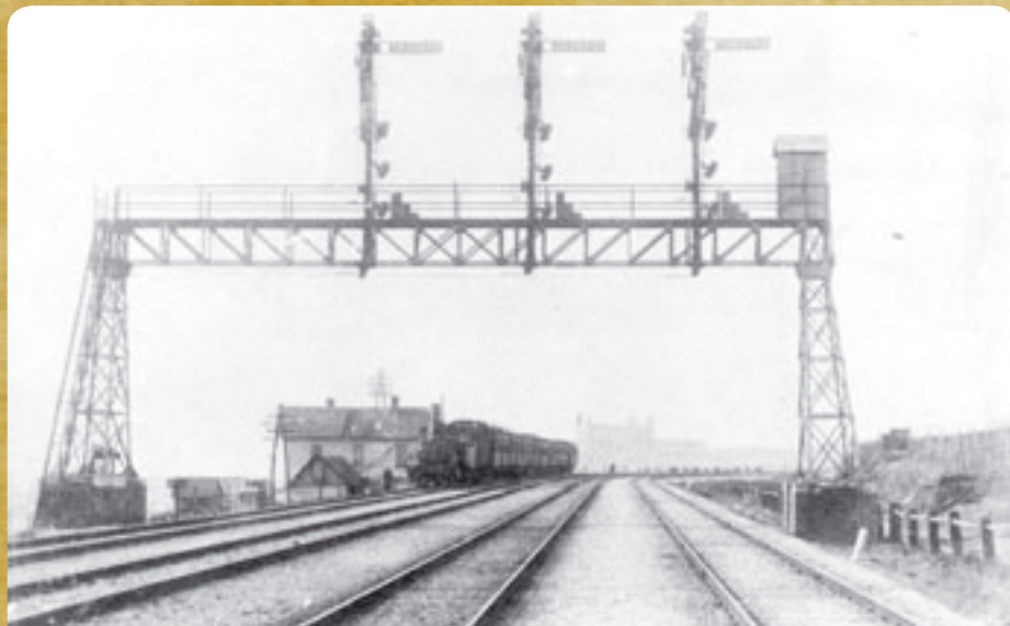
Návestná lávka s trojramennými mechanickými návestidlami bola inštalovaná v Bratislave v roku 1893.
