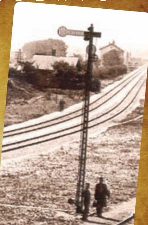
Dvojramenné návěstidlo. Najstaršia forma ramenového návěstidla z roku 1896.
