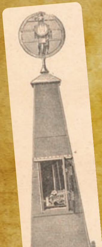
Dišťančné návestidlo. Schoenbachovo elektrické dišťančné návestidlo v dobovej teórii ...
