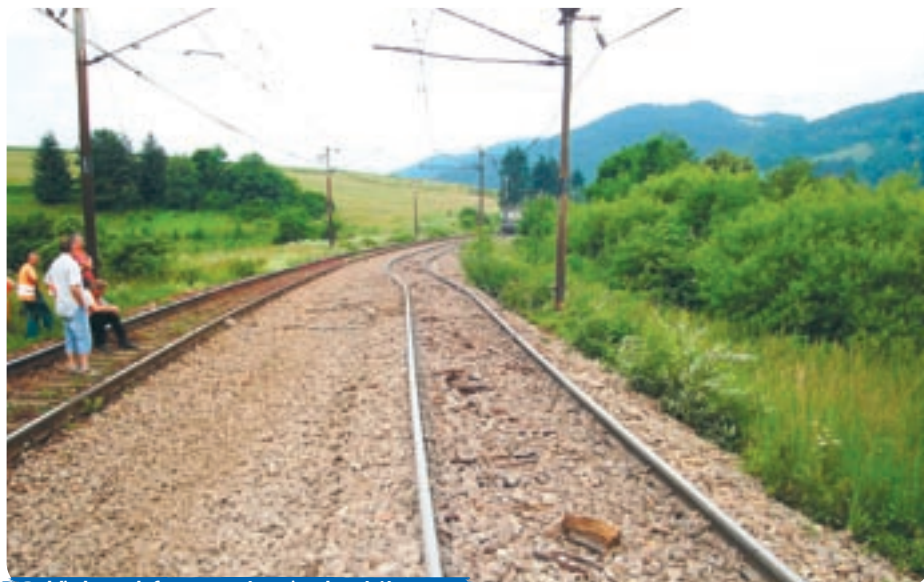
Pohľad na zdeformovanú trať po havárii.
