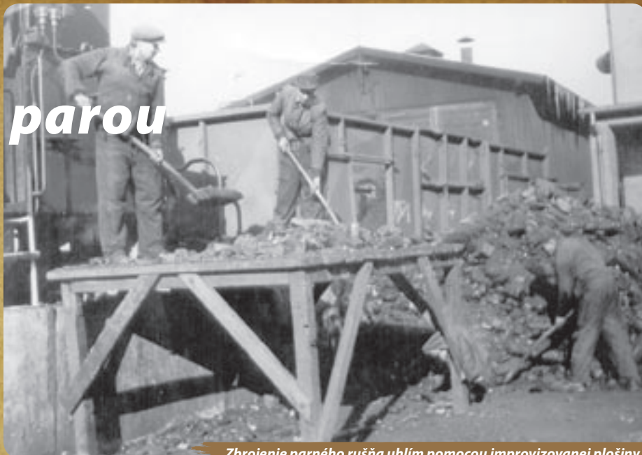
Zbrojenie parného rušňa uhlím pomocou improvizovanej plošiny.
