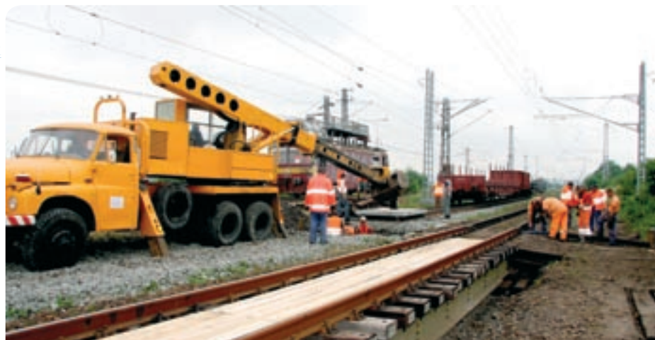
Mostné provizórium na prvej koľaji dvojkoľajnej elektrifikovanej trati je uložené. Teraz je na rade druhá koľaj.
