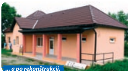
... a po rekonštrukcii.
