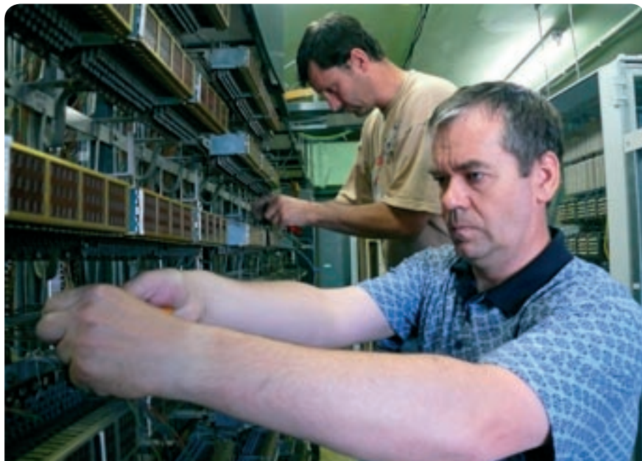
Stará analógová ústredňa už skončila svoju službu. Zamestnanci ŽT Žilina Ján Kucharík, špecialista hlasovej techniky, a technik Jozef Diky (vpravo) demontujú jej staré rozvody.
