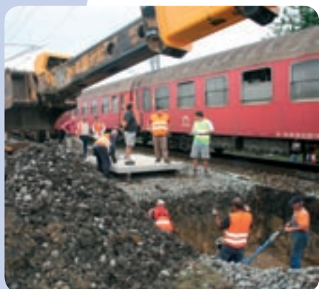
Kým mostári a traťováci pripravovali výkop pre mostné provizórium, na ostatných koľajach bola normálna prevádzka.
