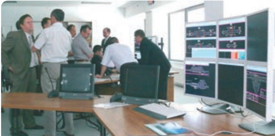
Z tohto dispečerského pracoviska v Trnave je možné obsluhovať až 19 dopravní a nákladíšť na úseku 87 km.
